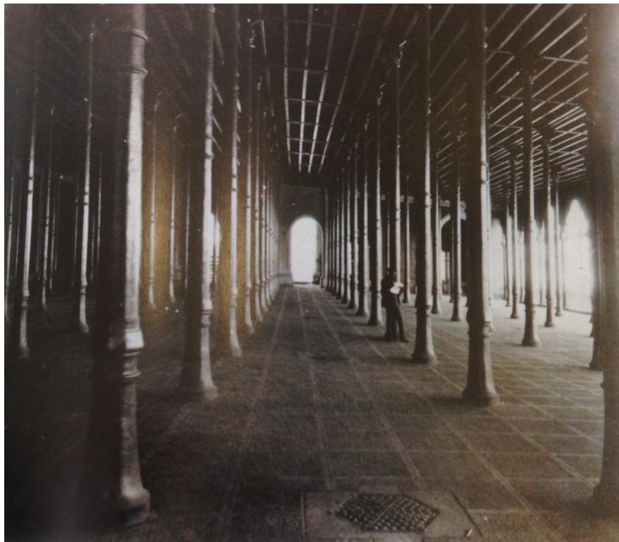
Ilustración 38 Interior del tercer piso del nuevo mercado con estructuras de acero prefabricadas, (el cual se perdió totalmente en el incendio) fuente: colección Federico Sescosse, Archivo Histórico de Zacatecas.
