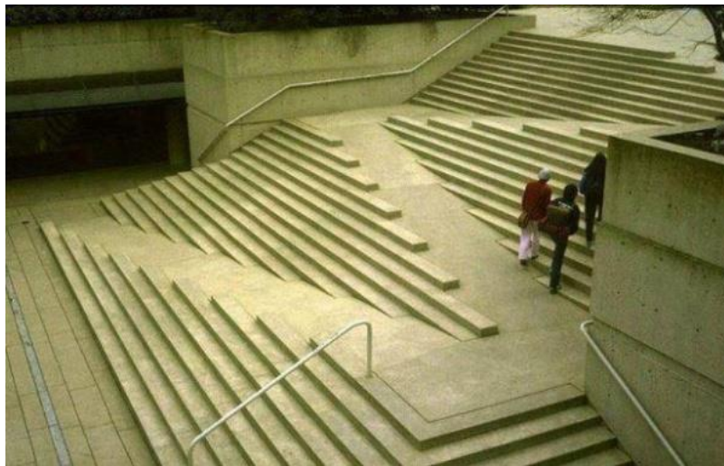
Ilustración 87 Ejemplo de cómo se podría implementar la rampa en las escalinatas de la Plaza Goitia, fuente: http://solucionista.es/la-rampa-escalera-plaza-pietri-otros-ejemplos
