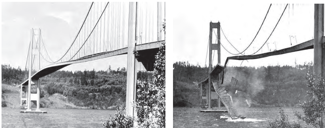
Figura 1- 2 Colapso del puente Tacoma Narrows
