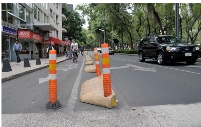
Figura 5.3.28 Ejemplo de ciclo vía unidireccional ( www.obrasweb.com )
