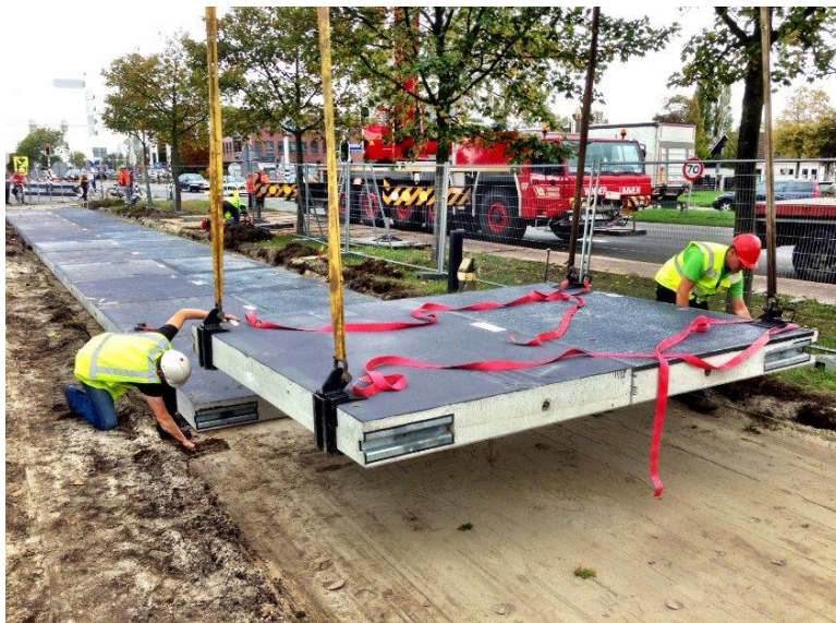
Figura 6.10 Instalación de SolaRoad (deepresource.wordpress.com)
