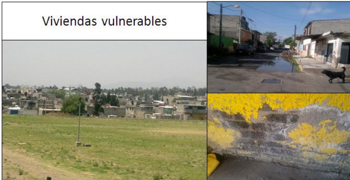
Figura 39. Vulnerabilidad. Ciudad Jardín más alta que colonia El Sol (izquierda); calle 38 (derecha arriba) con problemas de encharcamientos; paredes dañadas por la humedad en calle 40 (derecha abajo). Fotos: Diana Irán López, 2015.
