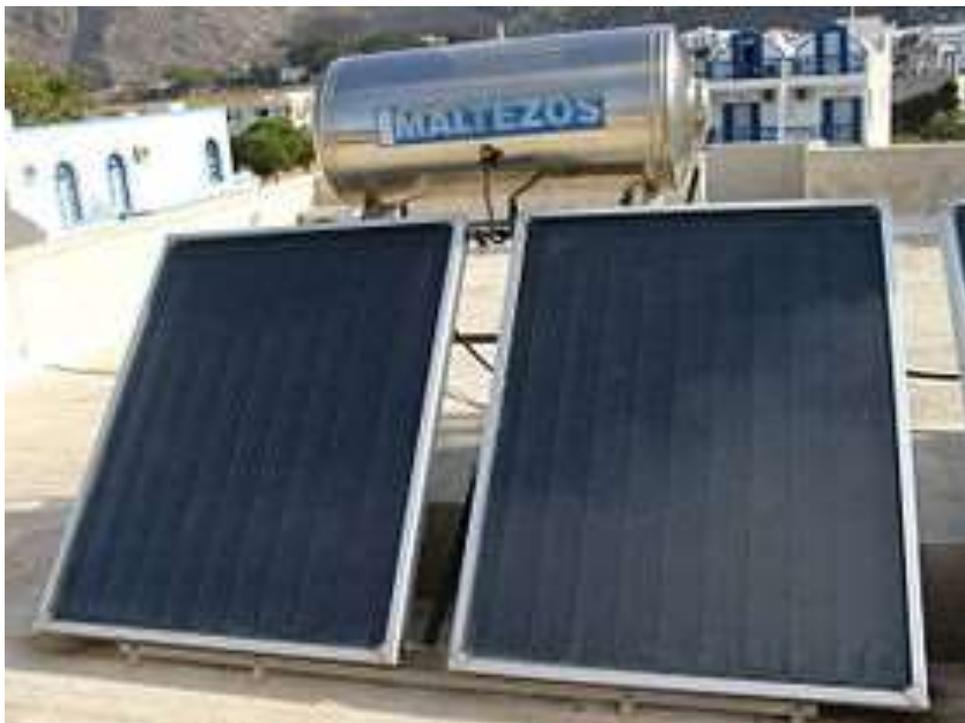
Un calentador solar es un aparato que utiliza el calor del sol (energía solar) para calentar alguna sustancia, como puede ser agua, aceite, salmuera, glicol o incluso aire. Su uso más común es para calentar agua para uso en albercas o servicios sanitarios (duchas, lavado de ropa o trastes etc.) tanto en ambientes domésticos como hoteles y otras industrias.
