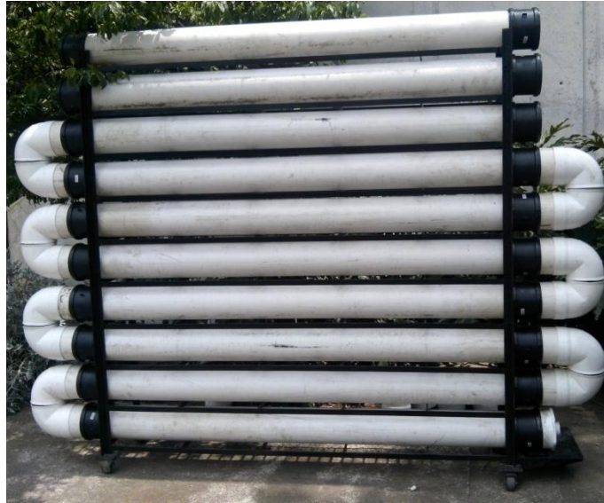
Figura 4.4 Colocación de codos en cada sección del reactor
