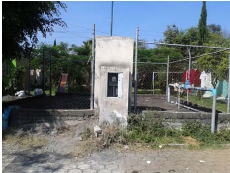
Fotografía. 3.5 En este punto se existe un cárcamo de bombeo donde el agua llega por gravedad desde el tanque elevado de la colonia San Rafael hasta otro tanque elevado donde se almacena y se controla la distribución.
