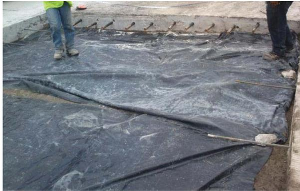
Figura 3.14. Superficie de sub-base tratada y cubierta con polietileno.
