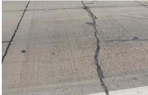
Figura 2.14. Agrietamiento transversal en losas de concreto hidráulico..
