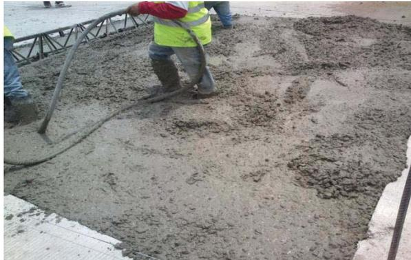
Figura 3.21. Vibrado del concreto hidráulico.
