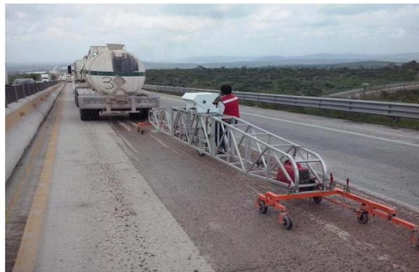
Figura 6.4. Obtención del índice de perfil, posterior a los trabajos de perfilado y texturizado
