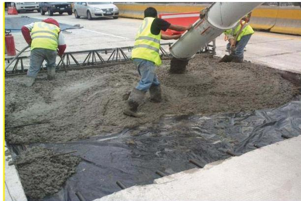
Figura 3.20. Colocación del concreto hidráulico.
