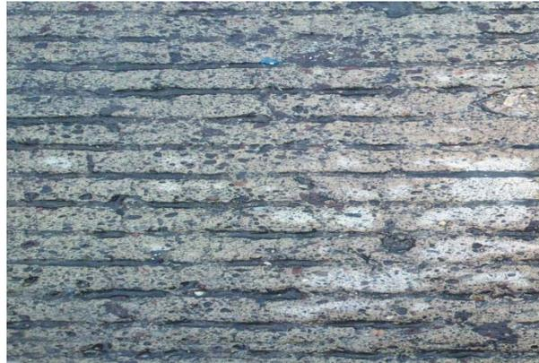
Figura 6.3. Superficie de rodamiento sobre la cual se obtuvo el índice de perfil, previo a los trabajos de perfilado y texturizado.
