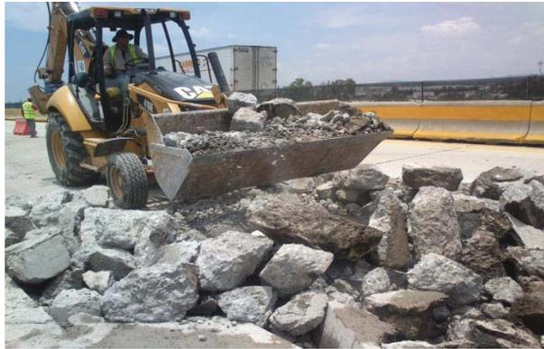
Figura 3.13. Extracción del material producto de la demolición.
