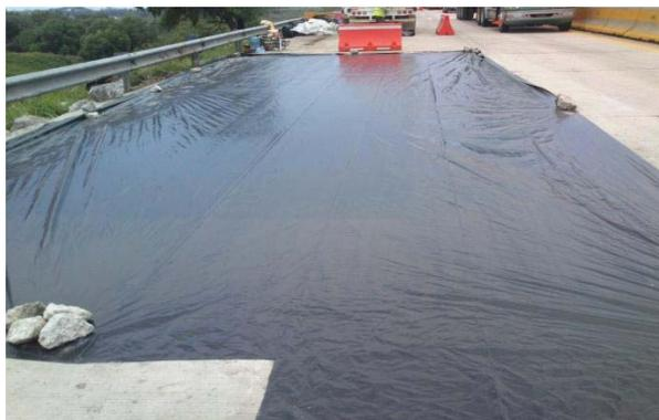
Figura 3.23. Curado y protección con poliestireno de las losas.
