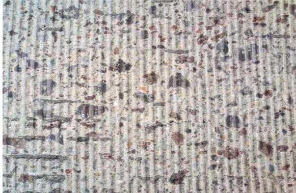
Figura 6.5. Superficie de rodamiento sobre la cual se obtuvo el índice de perfil, posterior a los trabajos de perfilado y texturizado.
