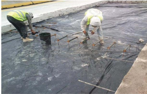
Figura 3.16. Colocación y tratamiento antiadherente de barras pasajuntas.
