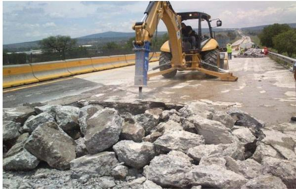
Figura 3.12. Demolición del área por tratar.
