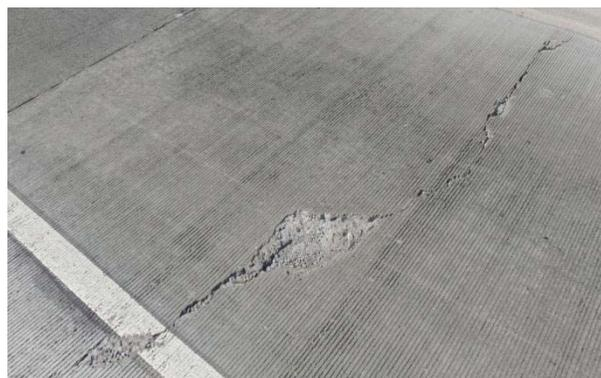
Figura 2.15. Desportillamiento en losas de concreto hidráulico..
