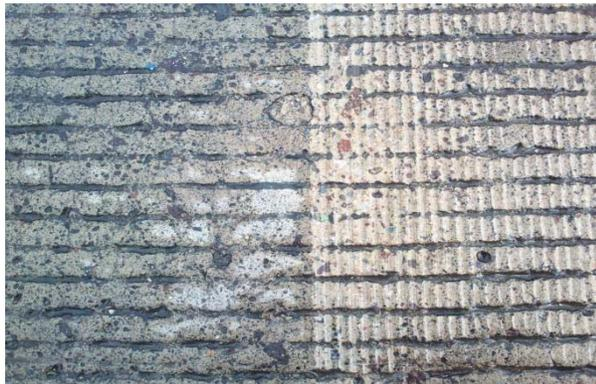
Figura 3.27. Superficie sin perfilar y texturizar (izquierda); superficie perfilada y texturizada (derecha).
