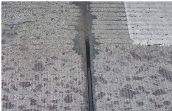
Figura 3.24. Material de sellado en junta de contracción.
