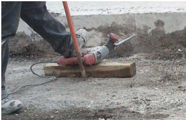
Figura 3.15. Perforación de orificios para la reposición de pasajuntas.
