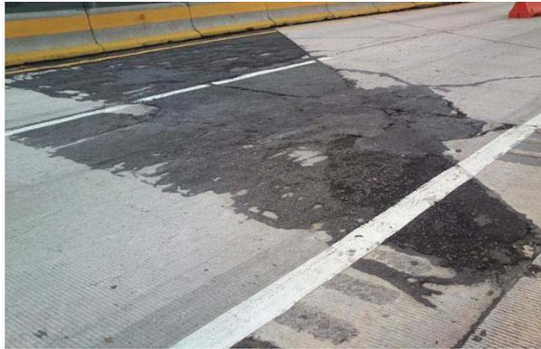
Figura 2.18. Deterioro superficial en losas de concreto hidráulico..
