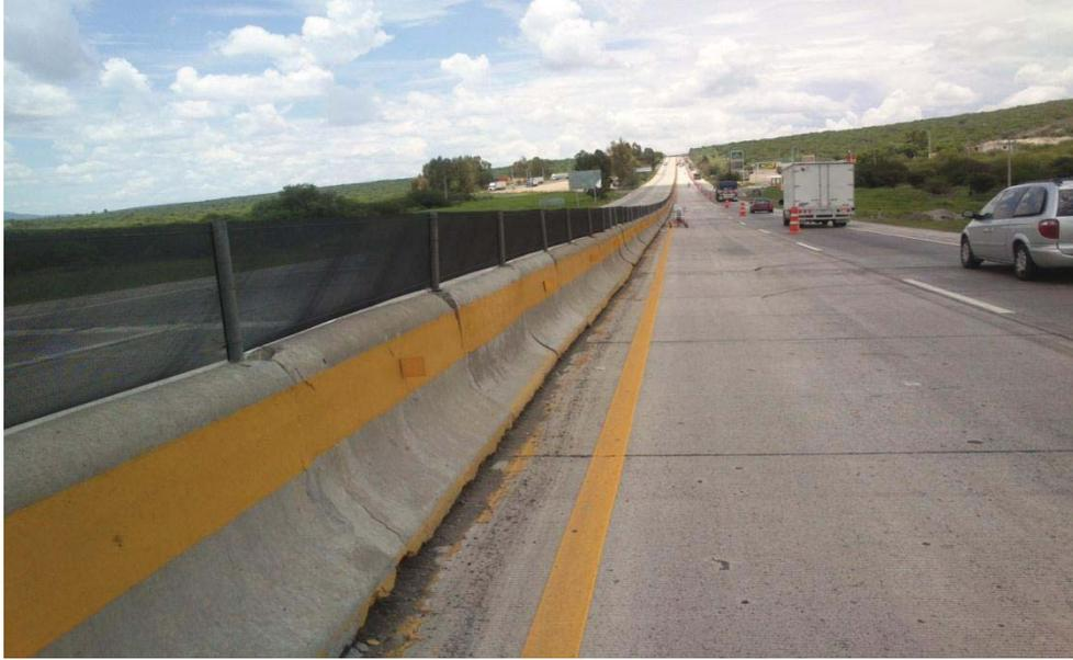
Figura 4.11. Avance parcial de perfilado y texturizado del carril de alta, cuerpo B.
