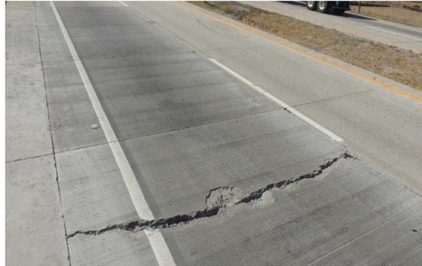
Figura 2.16. Falla estructural en losas de concreto hidráulico..
