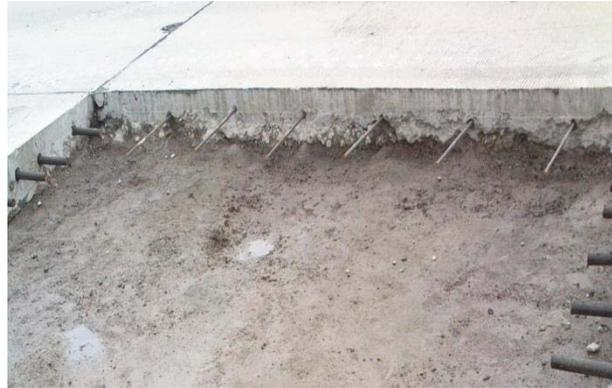
Figura 3.17. Barras de amarre colocadas en las juntas longitudinales de las losas.
