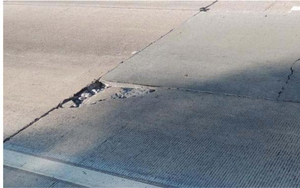
Figura 2.17. Despostillado de juntas en losas de concreto hidráulico..
