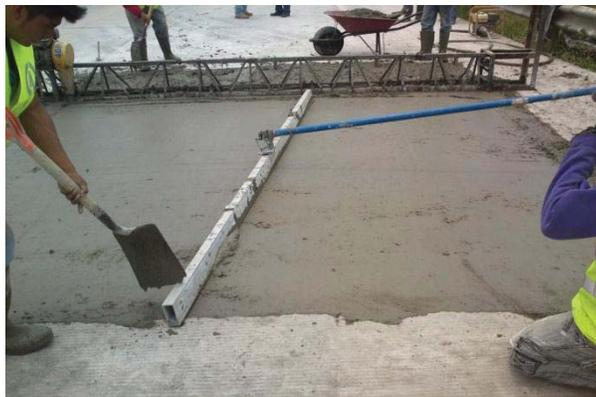
Figura 3.22. Enrazado y acabado de las losas.
