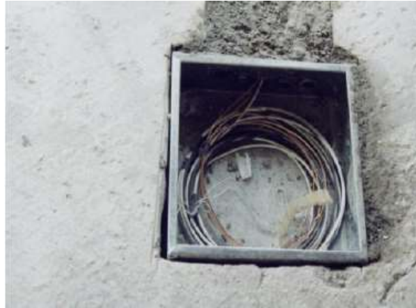
Figura 1.3 Instalación eléctrica totalmente oculta o ahogada.
