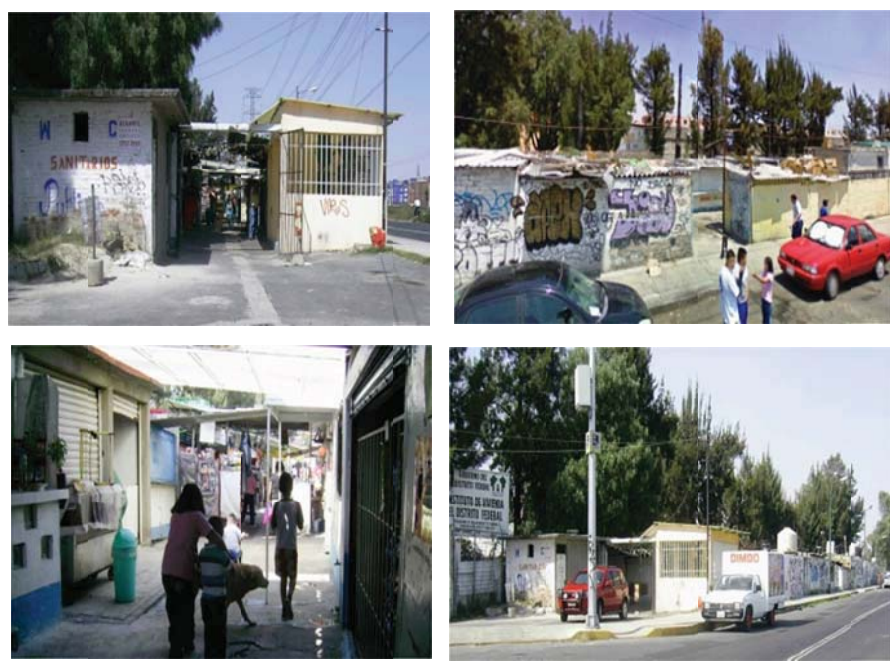
Estado actual del mercado “El Coyol”.
