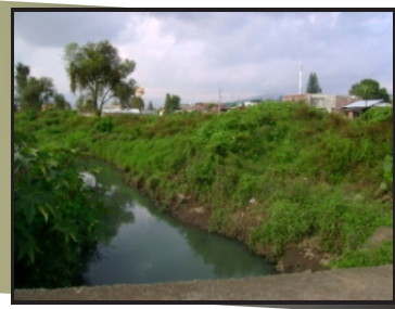
Vista de sur a norte Enero de 2009
