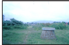
En el terreno atraviesa un colector de aguas residuales. Y de acuerdo al departamento de URBANISMO se considera como río y se debe construir a partir de los 5.00 m de cada orilla
