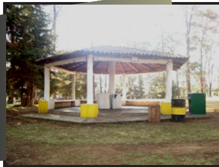
Cenador de madera, las columnas descansan sobre una base de concreto, para evitar la humedad
