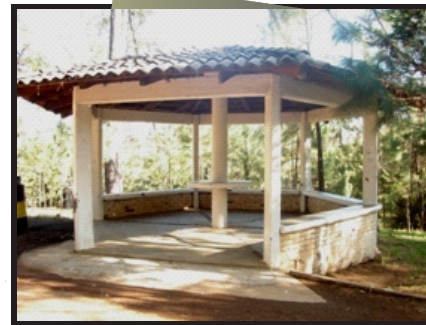
Cenador con estructura de concreto y techo de madera con teja de barro
