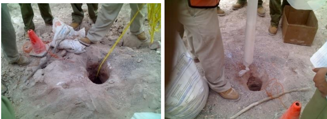
Ilustración 21. Cargado de barrenos
