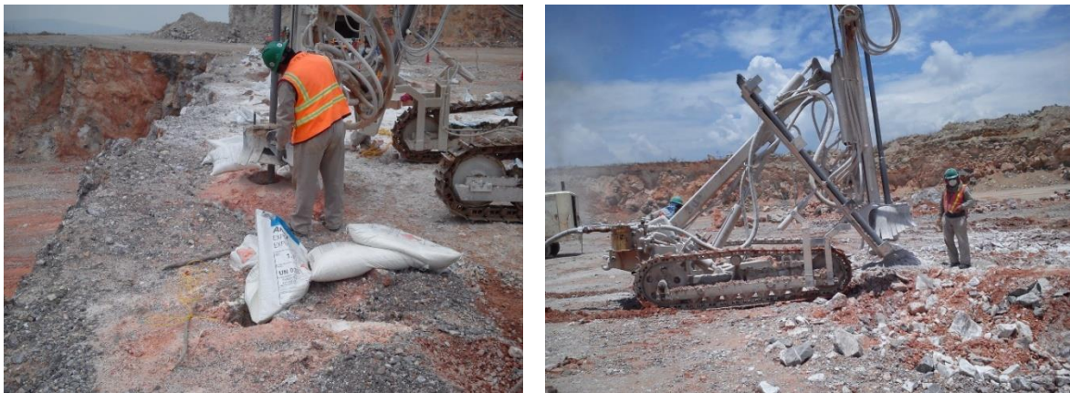
Ilustración 20. Perforación con Track Drill
