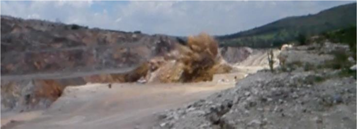
Ilustración 22. Voladura en progreso
