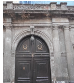
Fig. 73 Fachada de la casa de Castera. México, D.F. (detalle) (06/08/2014).
