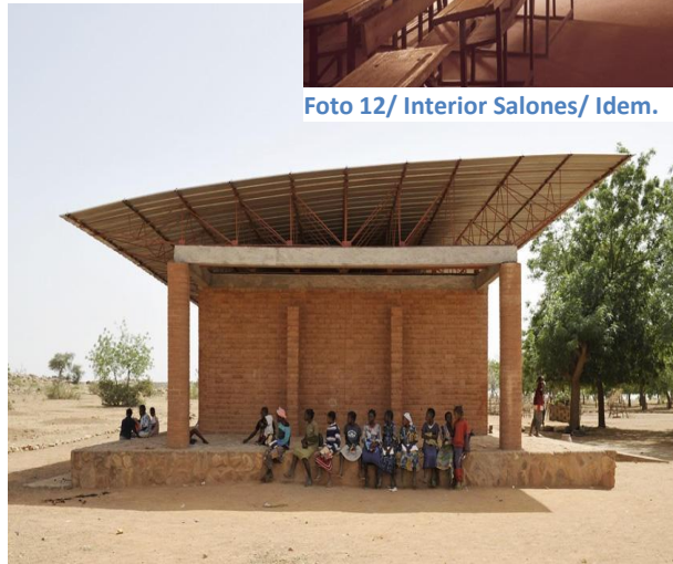
Foto 11/Fachada Lateral. Idem
