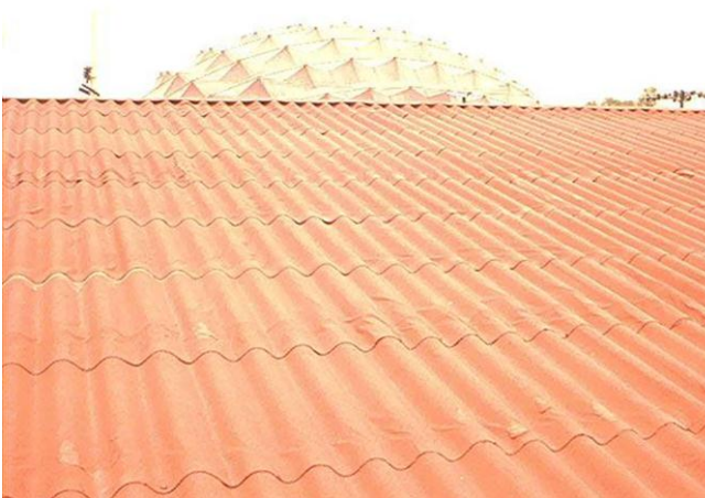
Ilustración 2: uniones de lámina de asbesto
