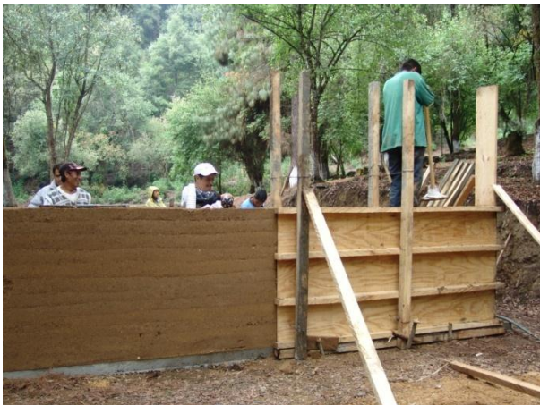
Taller de autoconstrucción con tierra compactada, realizado en sitio.
