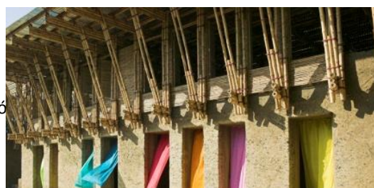
Foto 5. Fuente: Small Scale Big Changes. 2009. Fachada Este.
