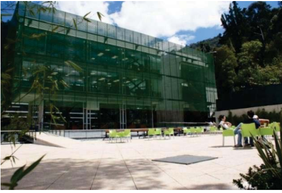
Imagen 2.7 Fachada interior Polideportivo de la Universidad de los Andes.
