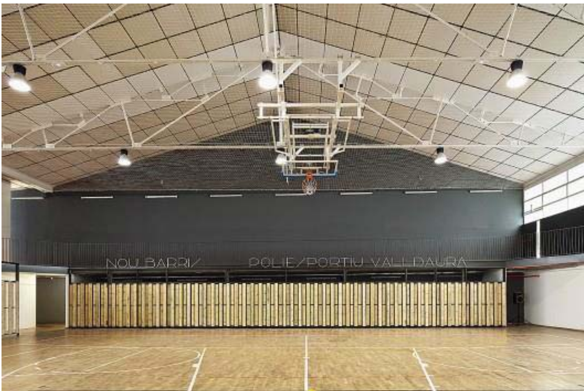
Imagen 2.5 Polideportivo Valldaura Arquitecto: Sulkin Marchissio SCP Ubicación: Barcelona, Cataluña, España Área Proyecto: 1,700 m 2
