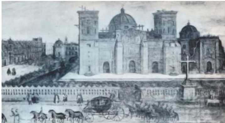
Imagen 3. La Catedral de la Ciudad de México en proceso de construcción en una fecha posiblemente posterior a 1760. Fuente: http://www.mexicomaxico.org/zocalo/zocalo.htm . Consultado el 18 de mayo del 2015.
