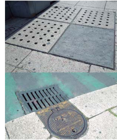
Imagen 28. Drenaje y Alcantarillado. Fuente: Elaboración propia. el 27 de Julio del 2015.
