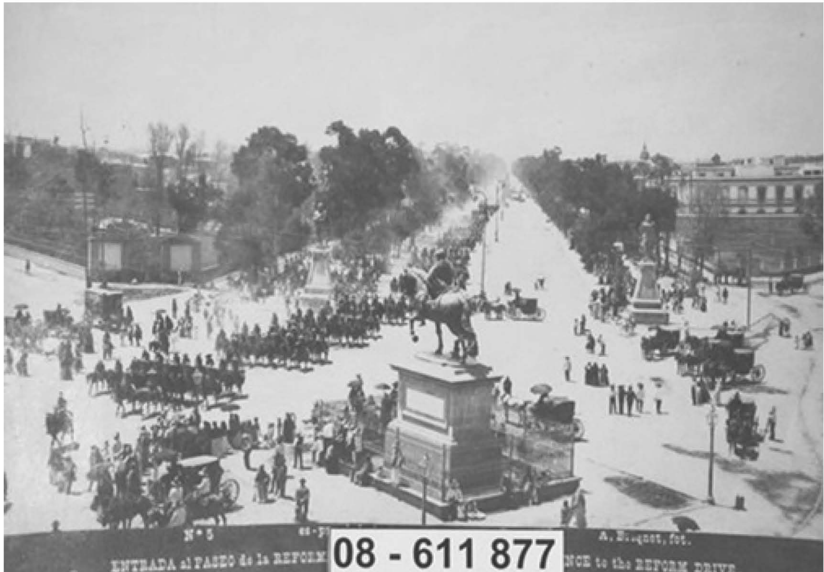
Entrada a Paseo de la Reforma, Mexico, A. Briquet
