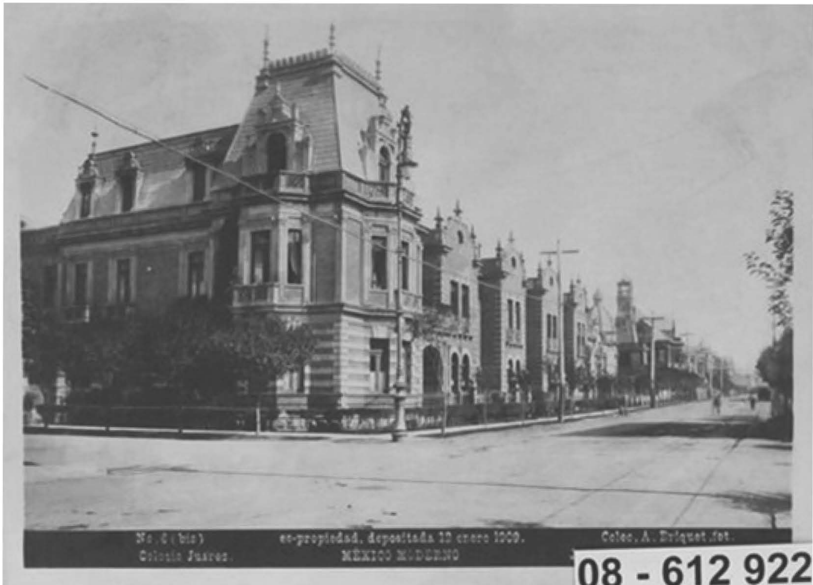
Colonia Juarez, propiedad depositada el 12 de enero de 1909 (VMéxico) A. Briquet
