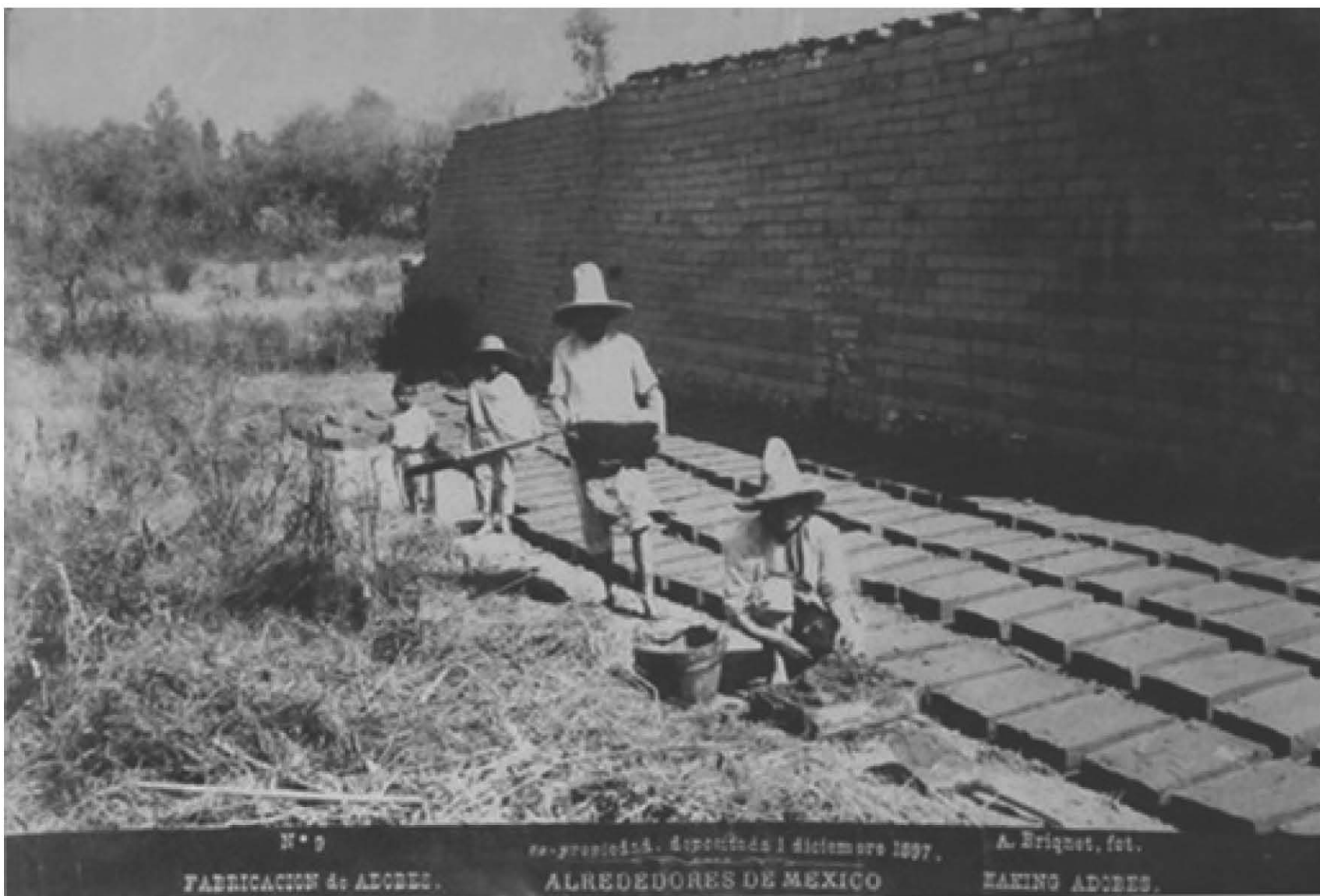
Fabricación de adobes, es propiedad depositada el 1 de diciembre de 1897(Mexico) A. Briquet
