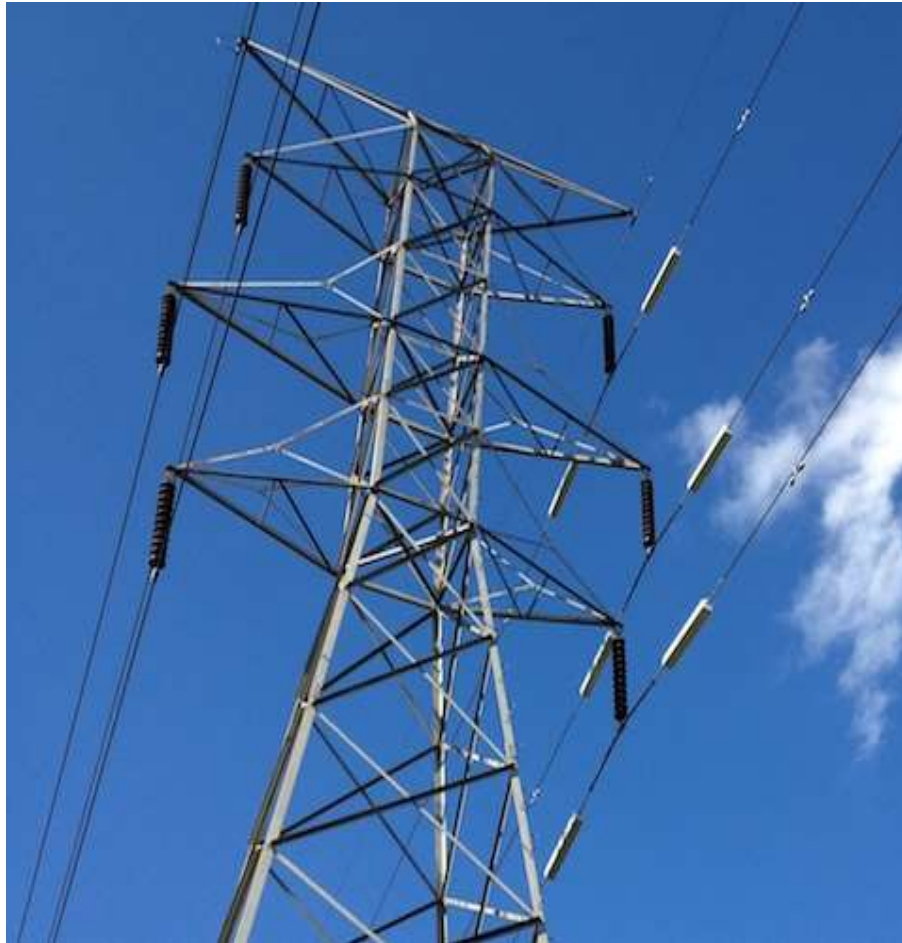
Figura 3.2. D-FACTS en líneas de transmisión real.
