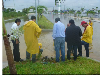
b) Basura de hojarasca, botellas de plástico, obstruyen rejilla de banqueta
