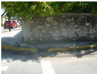
c) Tierra y basura amontonada que barre el usuario y la deja cerca de la rejilla de piso
