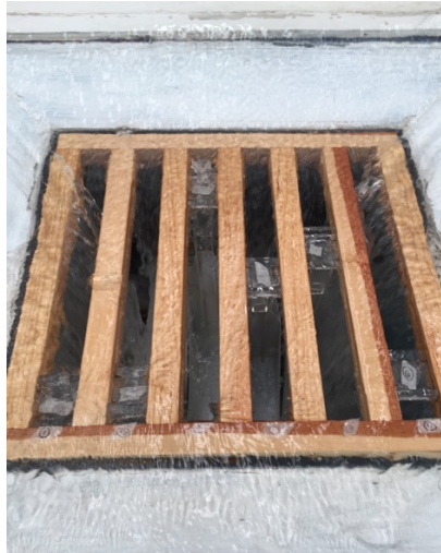
Figura 76 Carros barredores de la boca de tormenta autolimpiable en funcionamiento
