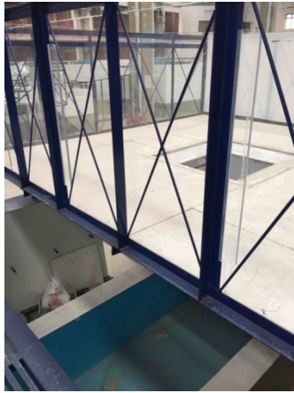
Figura 39 Tanque de almacenamiento
