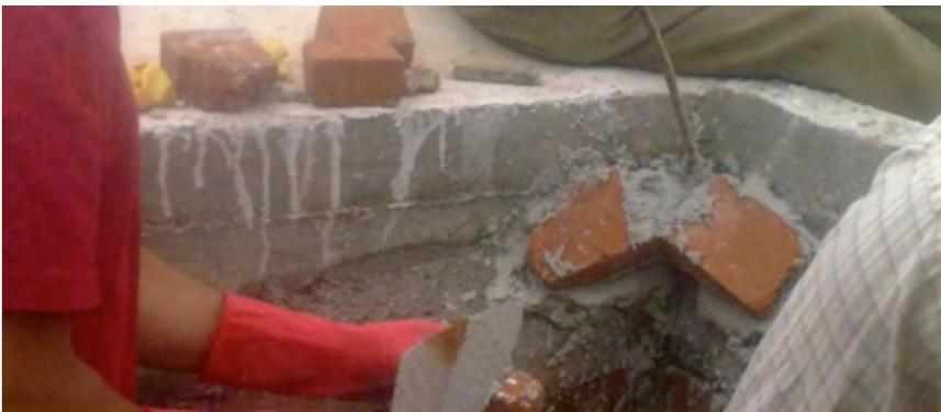
Figura 49 Colocación de segunda hilada.
