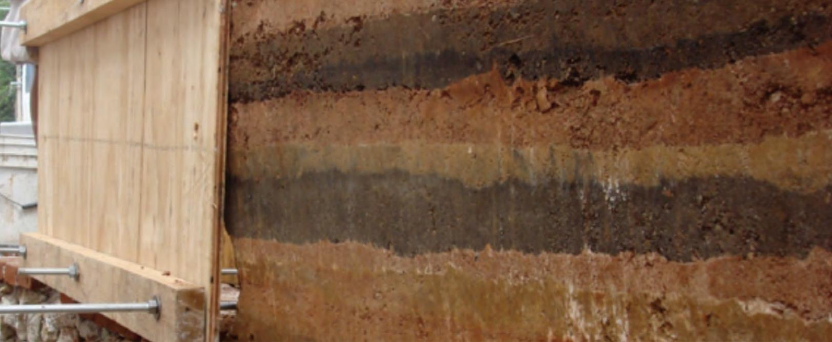
*Figura 42 Acabado de un muro de tapia. Fotografía por Marisol Guerrero.*
