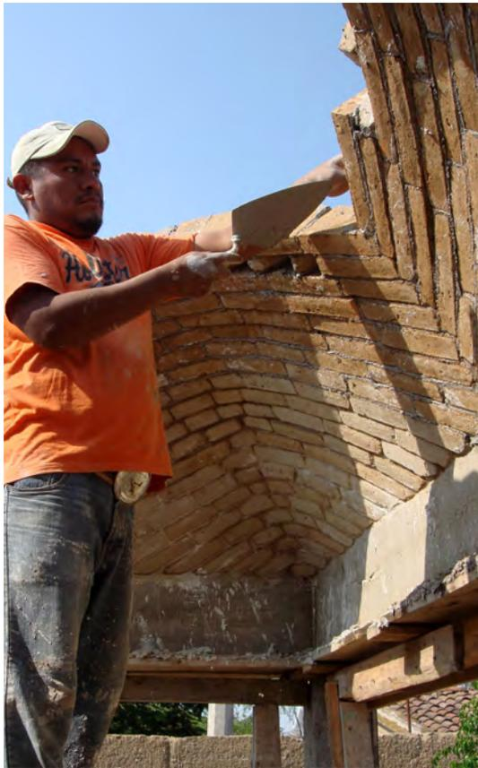
*Figura 46 Construcción de bóveda de tierra
