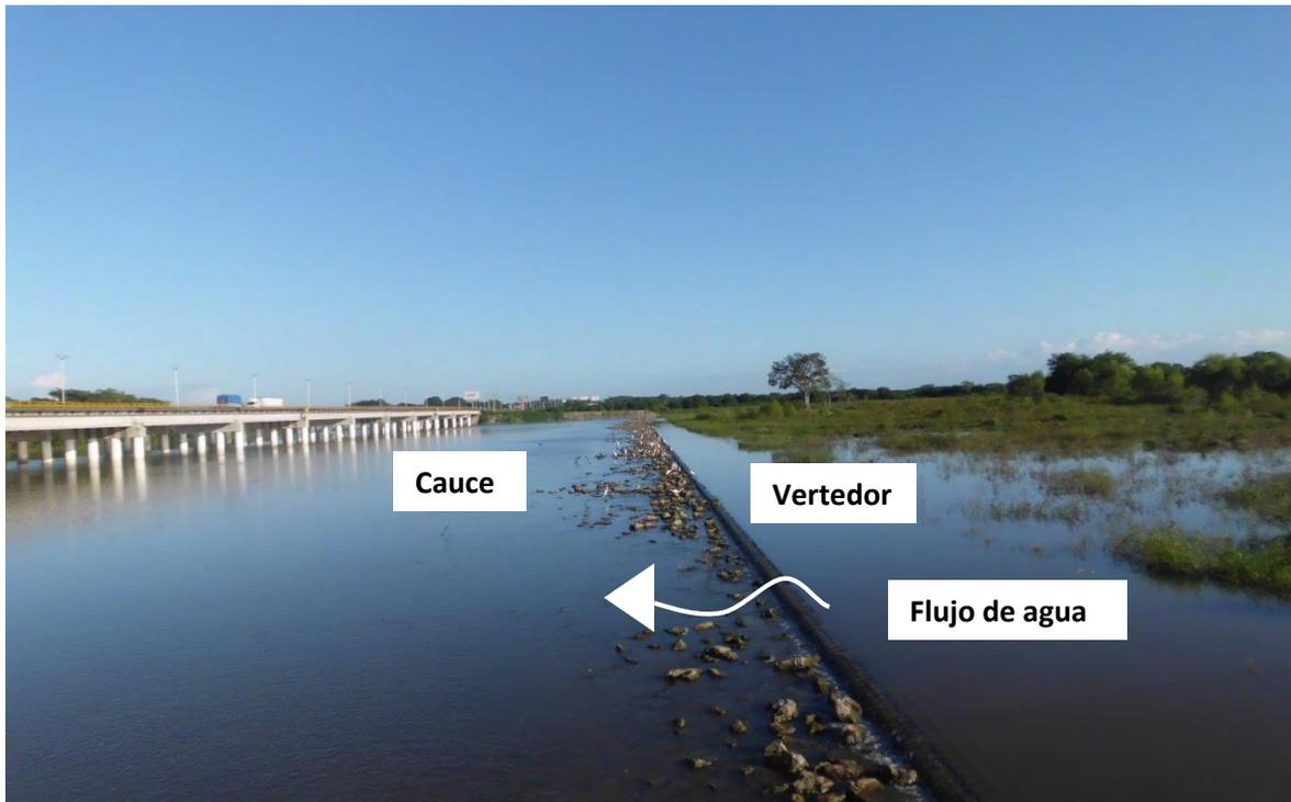
FIGURA 3.1.1.7 VISTA DEL VERTEDOR EN OPERACIÓN
