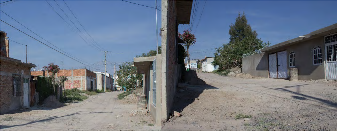
Fotografía 34 Daños sobre la calle Presa de la Olla se observa más que nada un desnivel en la calle de terracería y ser ha evitado construir en los terrenos por donde cruza la falla.
