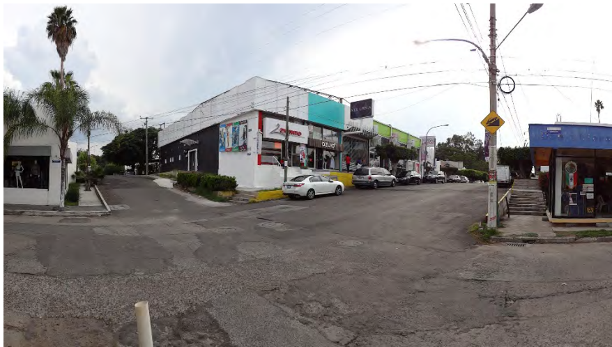
Fotografía 22 Esquina de las calles Agustín Arroyo Chagoyán y Nuevo León, en la fotografía se observa el caro desnivel en ambas calles y hay hasta un señalamiento vehicular de rampa y hay una gran escalinata en la banqueta.
