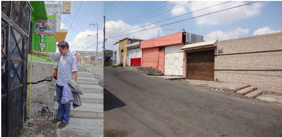
Fotografía 18 En la calle Francisco I. Madero se observa un desnivel más pronunciado de alrededor de 1.50 m se observan daños significativos en las bardas de las casas y la construcción de dos conjuntos de escalones
