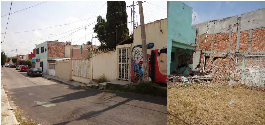
Fotografía 4 Sobre la calle Pedro de Gante también se pudo seguir el desnivel sobre la calle y los daños en una casa habitación la cual fue abandonada por el estado en el que se encuentra.
