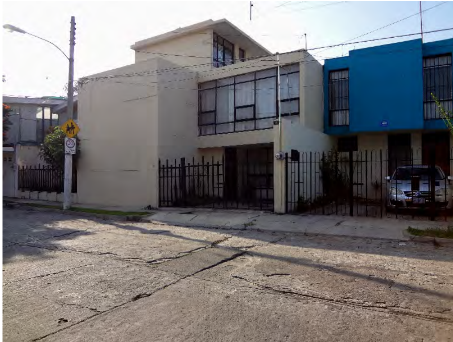
Fotografía 13 Sobre la calle Yucatán sólo se observaron agrietamientos en el pavimento y el las banquetas.
