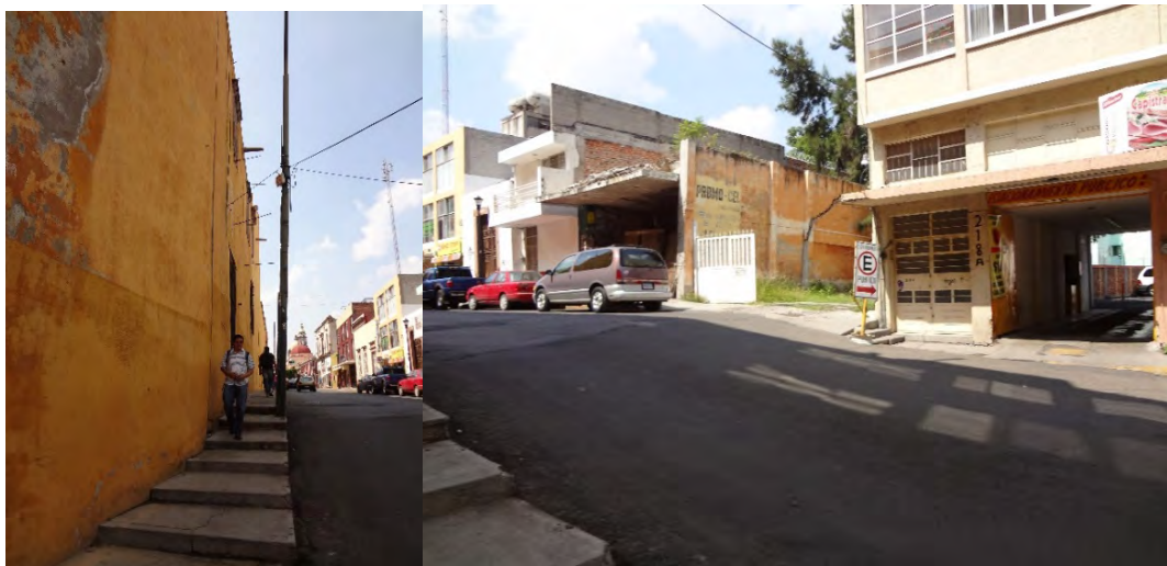
Fotografía 9 Calle Francisco I. Madero se observa el desnivel sobre estas calles y daños en la Iglesia de la Purísima concepción y en un estacionamiento frente a la iglesia.
