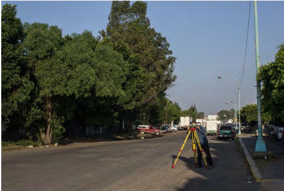
Fotografía 35 Sobre la calle Poniente 4 se distinguió a penas un desnivel sobre la acera frente a un centro de entrega de trasportistas de alrededor de 50 cm.
