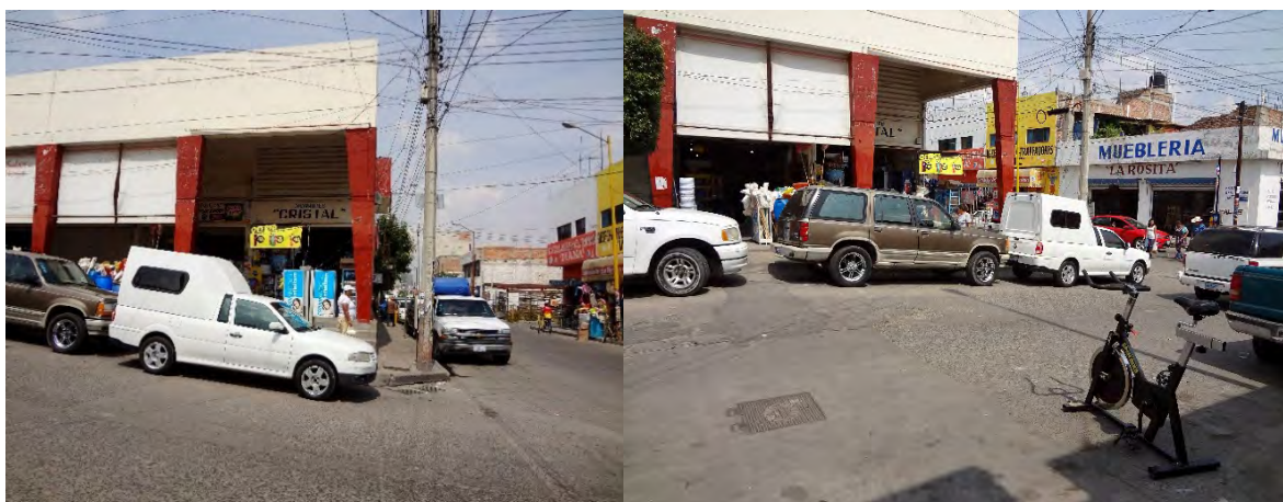
Fotografía 2 En la calle Francisco Villa frente al mercado "El Dorado" se observó un desnivel que afecta a dicho lugar aún que su ubicación no queda tan cerca de la falla Oriente
