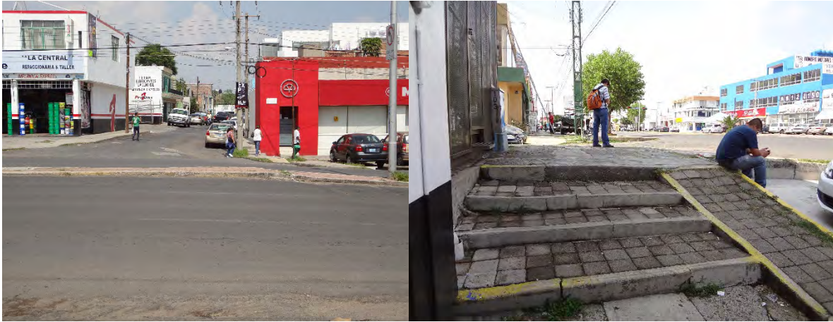
Fotografía 15 Esquina de la Blvd. Adolfo López Mateos y Calle Ocio y Ocampo se observa un desnivel de aproximadamente un metro que ha afectado la banqueta donde se han colocado cuatro escalones.
