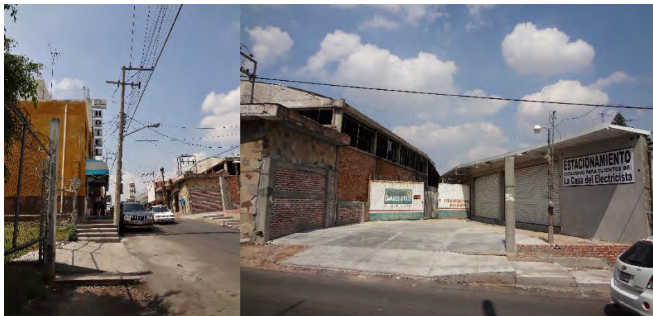
Fotografía 17 Calle José María Morelos se observa un claro desnivel de 1.50 m y se observan claros daños en las construcciones y la construcción de escalones en las banquetas.
