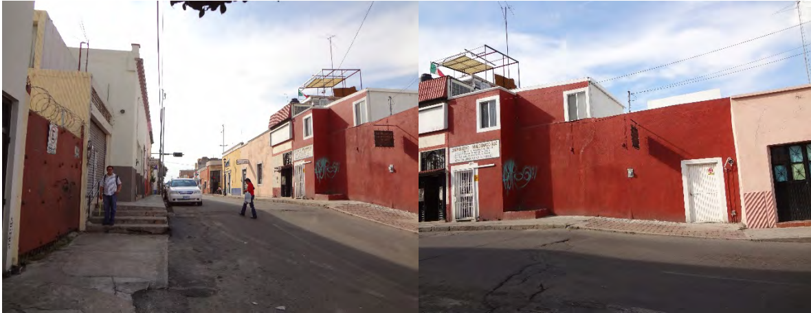
Fotografía 10 Calle 5 de Mayo se observa un desnivel de aproximadamente 70 cm, se colocaron escalones en la banqueta y daños en las bardas de las casas
