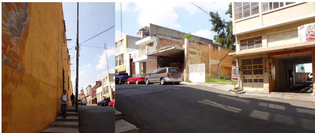
Fotografía 9 Calle Francisco I. Madero se observa el desnivel sobre estas calles y daños en la Iglesia de la Purísima concepción y en un estacionamiento frente a la iglesia.
