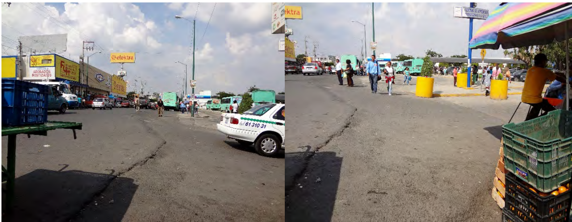
Fotografía 3 Calle Antonio Plaza frente a la central de autobuses se observa como un desnivel afecta la calle de manera diagonal quedando en el nivel inferior la central camionera.
