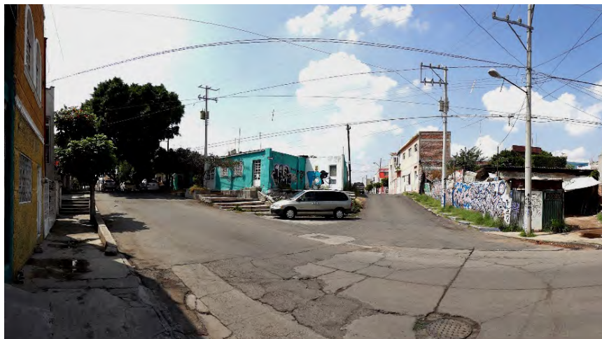
Fotografía 20 Calle Río Bravo se observa un desnivel aproximado de 1.60 m podemos ver dos casa afectadas en la esquina de la cuchilla un terreno baldío y la construcción de escalones en las banquetas
