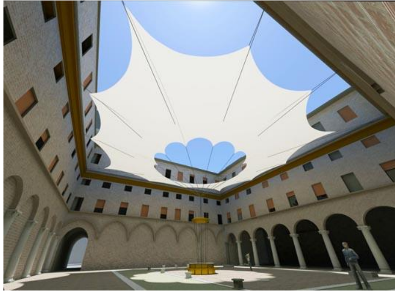
Figura 16: Cubierta para el castillo de Ferrara. 52
