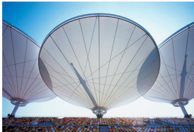
Figura 13: Tribuna del circuito internacional de Shanghai protegidas por estructuras tensadas. 47
