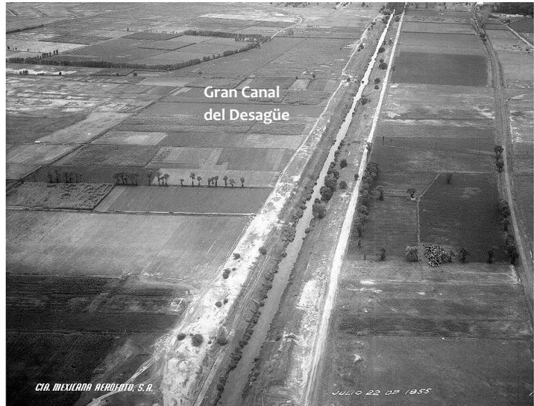
El Gran Canal del Desagüe cuenta con dos túneles para desalojar los escurrimientos fuera de la Cuenca de México. El primero comenzó a funcionar en 1900 y el segundo túnel inicia operaciones en 1950.<sup>11</sup>
