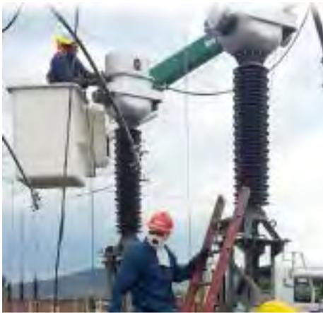
Figura 2.23 Transformadores de corriente subestación de distribución
