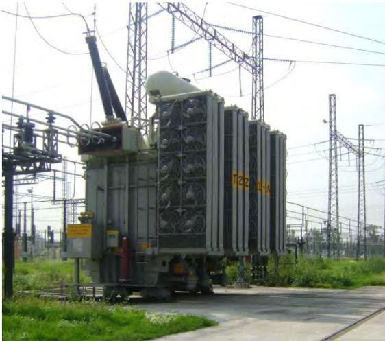
Figura 3.1 Transformadores de subestación de distribución
