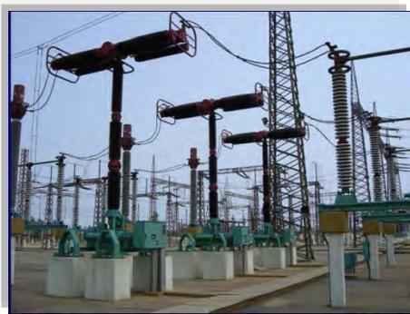
Figura 2.17 Interruptor de potencia en subestación de distribución
