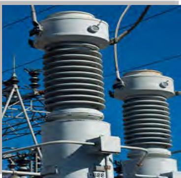
Los dispositivos eléctricos que permiten proporcionar las señales de corriente del sistema de distribución a los relés son los transformadores de corriente. Sus funciones básicas son:
