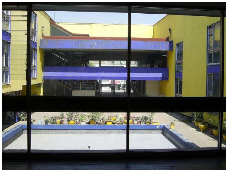
Ilustración 76 (vista a patio central)
