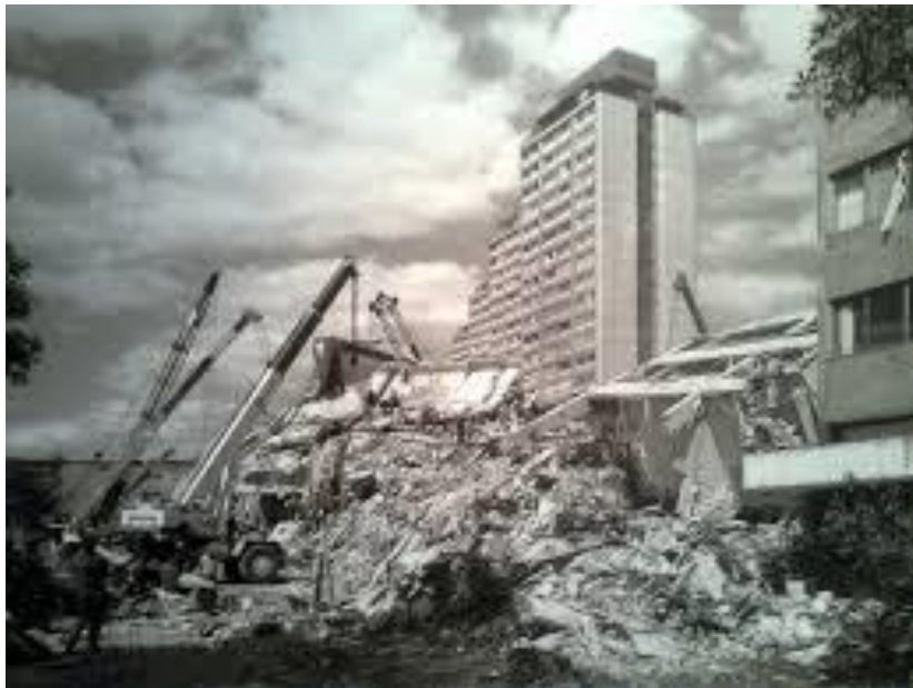
Ilustración 81 (daños sismo D.F.)
