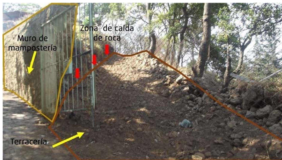
Fotografía 5. Obras de mitigación que consisten en un muro de mampostería de 40 cm, enmallado y una berma artesanal con el fin de evitar la caída de roca. (19.2142° N, 99.1000° W. Calle: Camino al Panteón).
