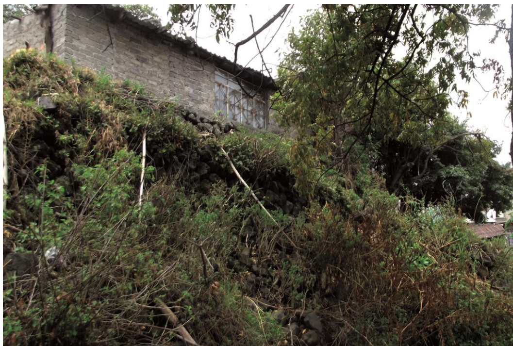
Fotografía 8. Vivienda a pie de ladera construida sobre muro sin mortero (19.2190° N, 99.1057° W. Calle: Jacarandas).
