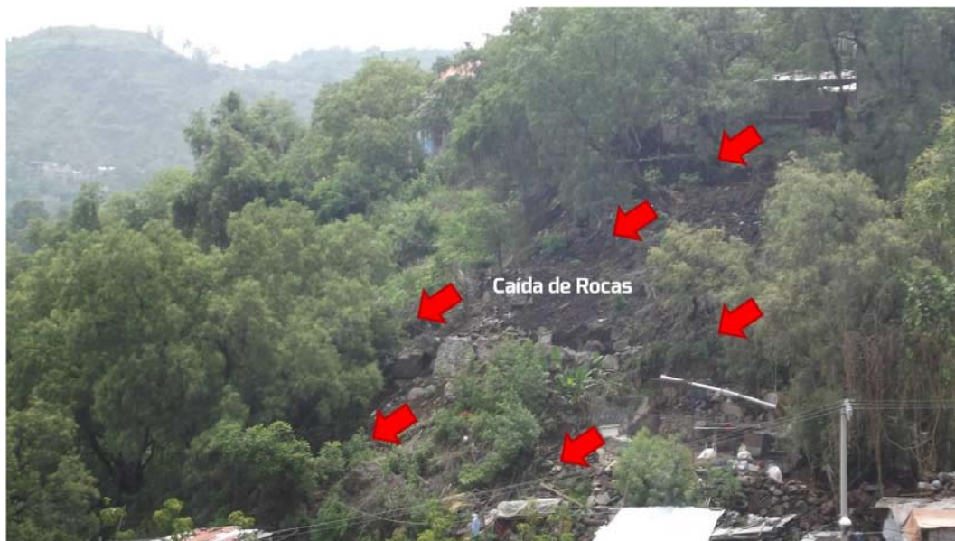
Fotografía 10. Peligro por caída de roca en Tecacalanco. (19.2467° N, 99.0663° W. Calle: Circuito Panamericano).
