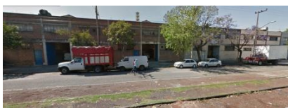
Imagen 2.3.Fachada norte estado actual.
