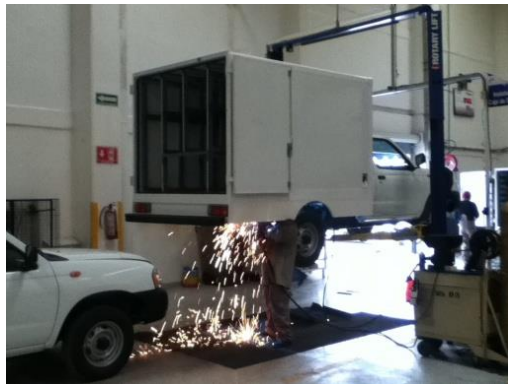
Figura 29. Instalación de la caja de seguridad.
