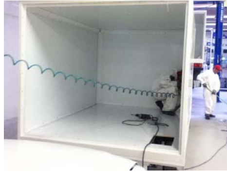
Figura 23. Instalación de toma de gasolina.
