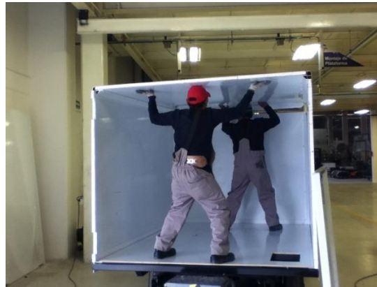
Figura 22. Instalación de paneles laterales y techo.
