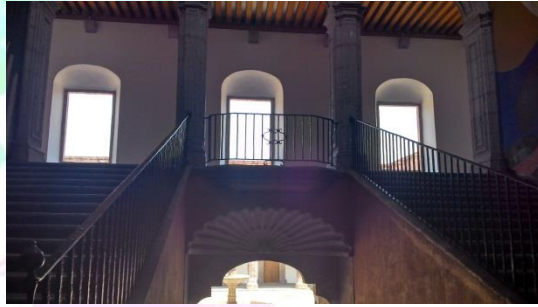
Núcleo principal de escaleras:
