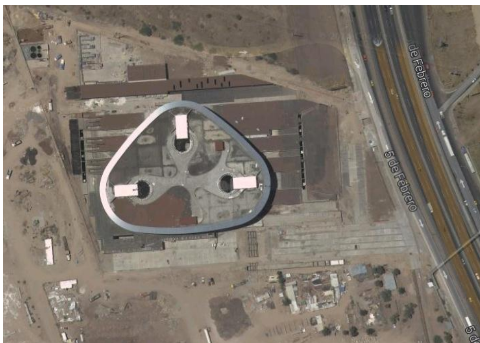
Fig. 57. Vista satelital del call center de Banco Santander en Querétaro en su fase de construcción 16
