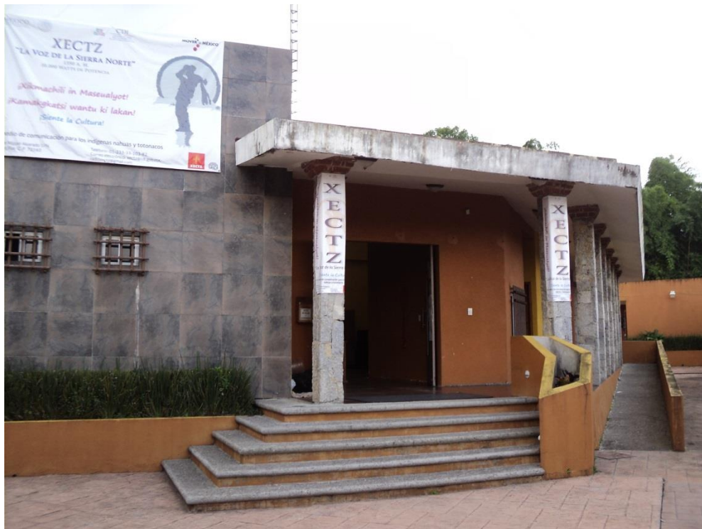
Instalaciones de la XECTZ, La Voz de la Sierra Norte / Fotografía del autor, 10 de octubre de 2014.
