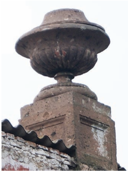
Fig. 90 Pebetero de cantera rosa sobre el pretil del portal de la Casa del Mayordomo. Foto: Isis Isidoro, 2015.
