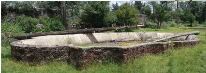
Fig. 92 Pila de trazo mixtilíneo, Mesón Arroyo Zarco. Foto: Isis Isidoro, 2013.
