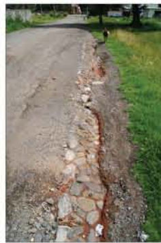
ARROYO VEHICULAR que va del portal de la hacienda al mesón. Se observa restos de empedrado debajo de la carpeta asfáltica, hipótesis de que sean posibles restos del Camino Real. Se propone hacer una cota para comprobar o rechazar hipótesis.
