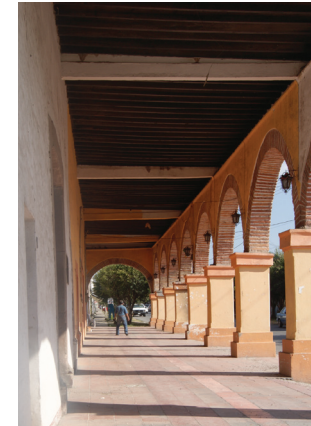
Fig. 37 Interior del portal. La cubierta de concreto armado es de reciente construcción. Foto: Isis Isidoro, 2015
