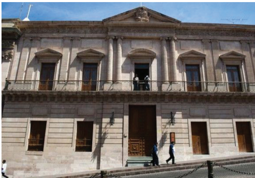
Fig. 68 Casa del Conde Rul, proyectada por el arquitecto Esteban González, en Guanajuato. El detalle del tablero arriba de la ventana balcón, se encuentra también en el Mesón Arroyo Zarco. Foto: http://jorgepalmieri.com/files/2012/03/get6.jpg
