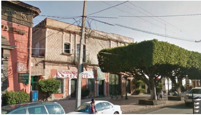
Fig. 39 Casa de Diligencias en San Juan del Río, actualmente en desuso, se localiza en la Av. Benito Juárez pte 24. La fachada es de ajaracas y los vanos con jambas corridas.
