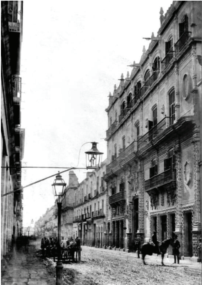
Fig. 97 Don Anselmo Zurutuza compró este edificio que elevó a un punto de aseo y lujo, colocándolo al nivel de los mejores establecimientos de Europa, poniéndole como nombre “Hotel Iturbide”.
