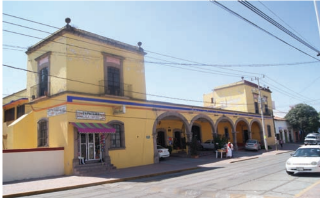
Fig. 26 Fachada principal del antiguo Mesón de Soyaniquilpan, sobre la Avenida Emiliano Zapata. Foto: Isis Isidoro, 2015.
