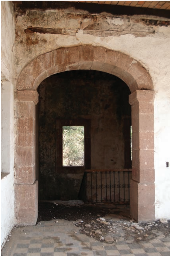
Fig. 66 Arco de desembarque de la escalera en planta alta del mesón Arroyo Zarco, en la clave de cantera está la inscripción del año en que se concluyó la obra. Foto: Isis Isidoro, 2013.
