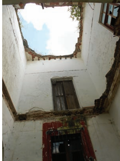
Fig.114 y 115 Colapso de entrepiso y cubierta detrás de la fachada del mesón.
