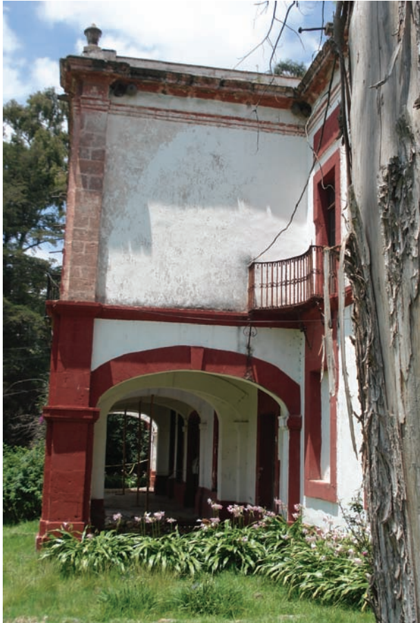
Fig. 78 Vista hacia el portal del mesón Arroyo Zarco donde se encontraban la tienda, salón y administración. Foto: Isis Isidoro, 2013.
