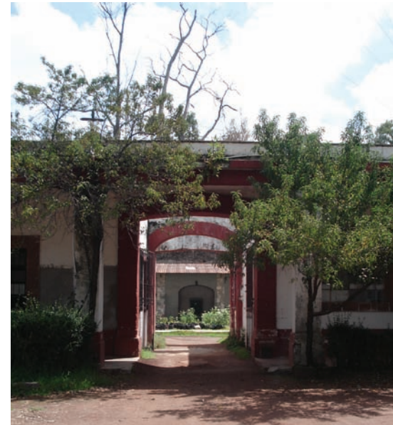
Fig. 71 Vista del patio principal hacia las caballerizas del mesón Arroyo Zarco, se observa una serie de arcos que compartimentan el corredor, a modo de remate está el arco del muro de las caballerizas. Foto: Isis Isidoro, 2015.
