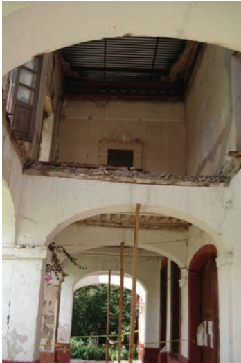
Fig.114 y 115 Colapso de entrepiso y cubierta detrás de la fachada del mesón.
