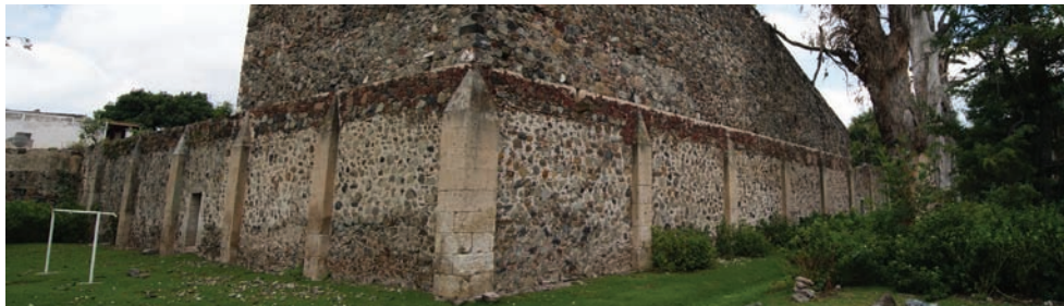
Fig. 89 Barda de la parte posterior del mesón Arroyo Zarco, se observan los contrafuertes de cantera blanca. Actualmente se alzó un muro sobre de ella que se usa como frontón. Foto: Fernando Ortiz, 2015.
