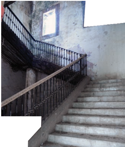
Fig.73 Escalera del mesón Arroyo Zarco, aún conserva el barandal de hierro forjado con cabezal de madera y ornamentación del mismo material. Foto: Fernando Ortiz, 2013.
