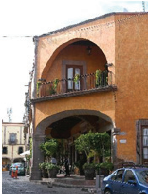
Fig. 42 Fachada principal del Mesón de Santa Rosa.
