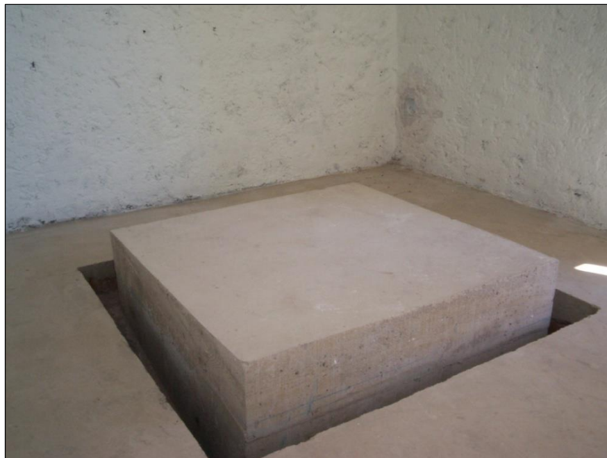
Figura 3.6 Colocación de pila o base para la instrumentación
