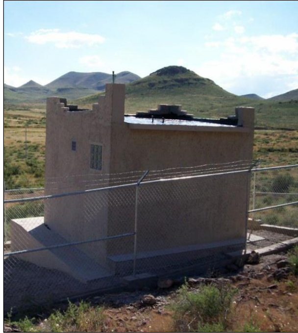
Figura 3.7 Pretil perimetral para el resguardo de las celdas solares y la antena
