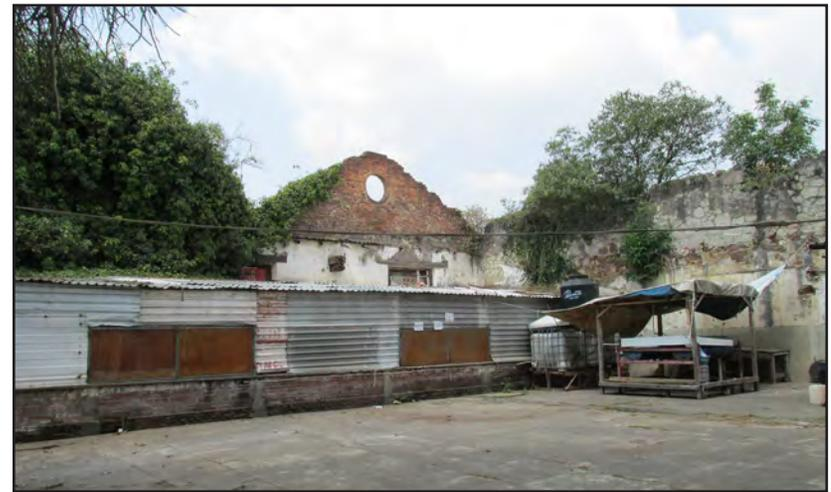
Fig.184. Imagen interior del área de trojes, en la que se observa que el inmueble a perdido totalmente su cubierta original y a sido objeto de intervenciones contemporáneas, agregándose piso de concreto, y edificando cuartos con lámina. Marzo 2015.
