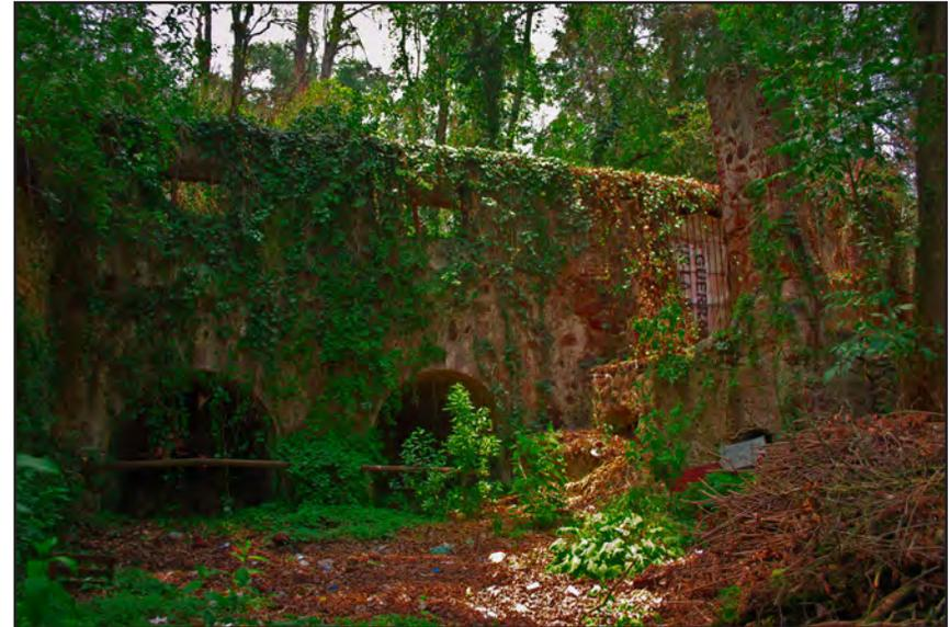
Fig.41 Fachada del molino de arriba de la hacienda Zavaleta, en la parte baja se aprecian dos cárcavos que corresponden cada uno a una parada de piedra, configuración que coincide con lo mencionado en la merced de los molinos. Fotografía Colaboración de Xochitl Noxpanco.
