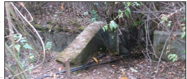
Fig.57. Imagen de elemento bloqueando la boca del canal principal y una compuerta a un costado, en el molino de arriba, la posición de la fotografía se indica en la planta arquitectónica. Marzo 2015.
