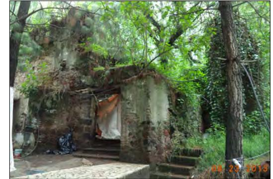
Fig.53. Imagen del molino de abajo, se observa su acceso principal, deterioros en su fachada, así como gran cantidad de vegetación parásita que se asienta en sus muros. Agosto 2013.
