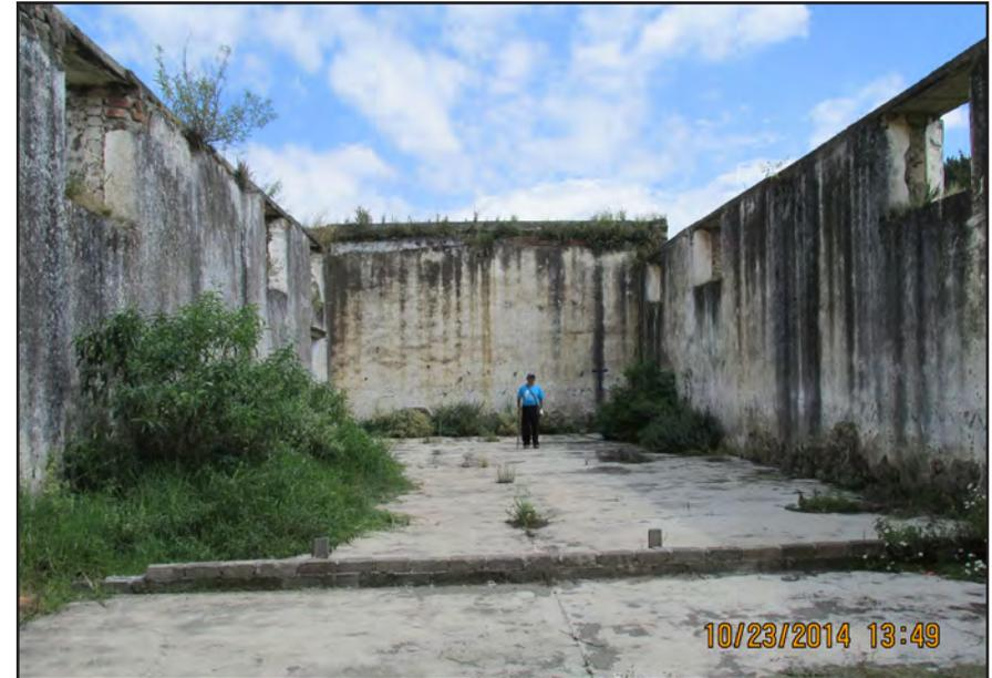
Fig.151. Ruinas de lo que parece haber sido una troje. En el plano in situ, se señala como "almacén" se puede apreciar la falta de cubiertas, la invasión de vegetación parásita y el agregado de un piso de concreto armado. Octubre 2014.
