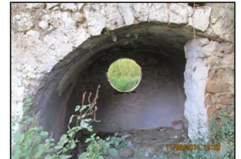
Fig.125. Interior del supuesto cárcavo 2, se observa su fábrica, e intervenciones contemporáneas, como la aplicación de pintura y un muro de ladrillo tapiando uno de sus lados. Noviembre. 2014.
