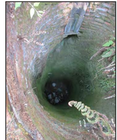
Fig.63. Imagen del interior de un cubo de los molinos de arriba, donde se aprecia su fábrica de ladrillo rojo recocido. Marzo 2015.
