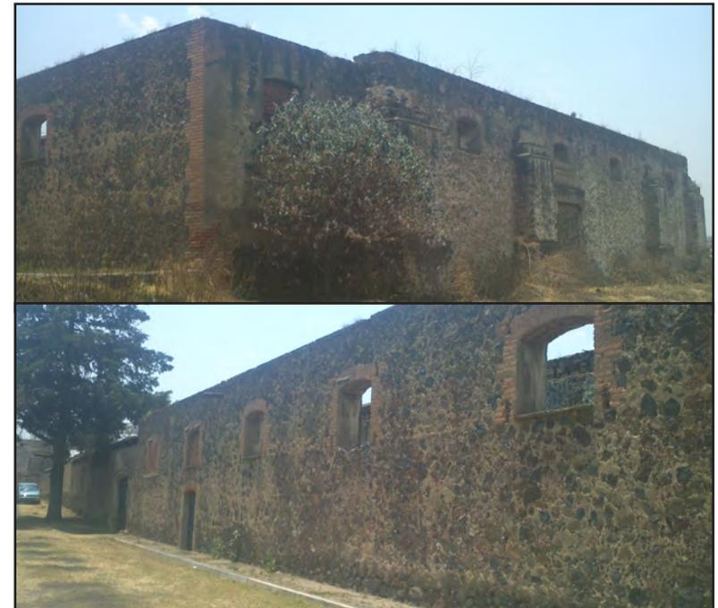
Fig. 153 - 154. Exterior del Rancho San José, donde se aprecian ventanas y puertas tapiadas, así como, vegetación parásita en la parte superior de los muros. Mayo 2013.
