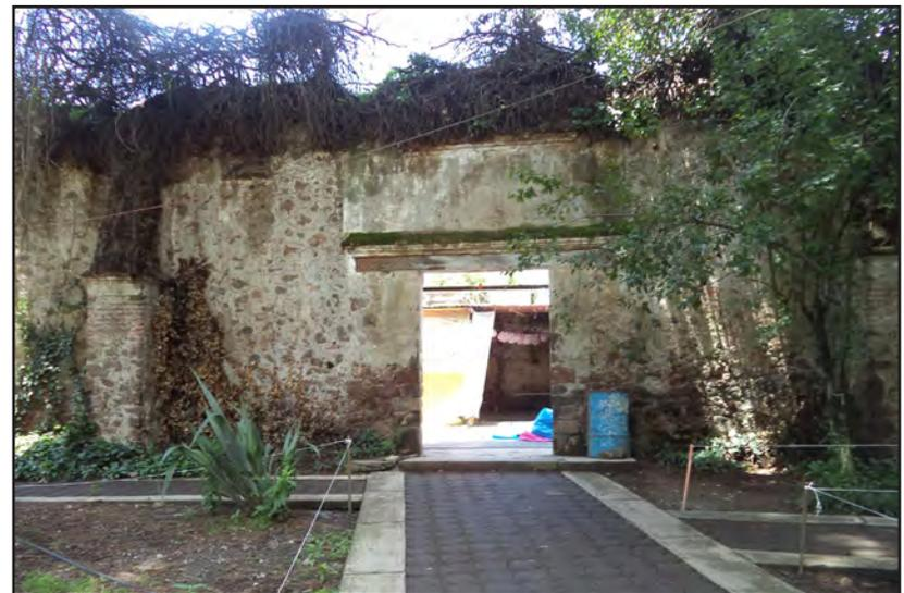
Fig.185. Imagen de uno de los accesos a las trojes, donde se aprecia la fábrica de sus muros, y un gran dintel de madera sobre la puerta, asimismo, nos podemos percatar de la gran densidad de vegetación parásita asentada en la cumbre del muro. Agosto 2013.
