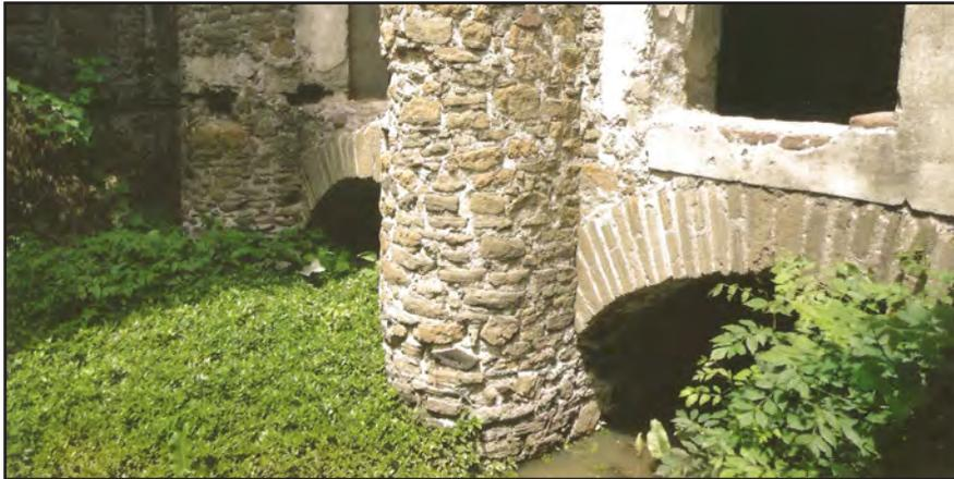
Fig.138. Imagen de los molinos de Xuchimangas, se aprecian dos cárcavos, con gran densidad de vegetación parásita creciendo en el área de desagüe de los mismos. Fuente: Pastrana Salcedo, Tarsicio. *Los molinos de Xuchimangas*. 2012, p.123.
