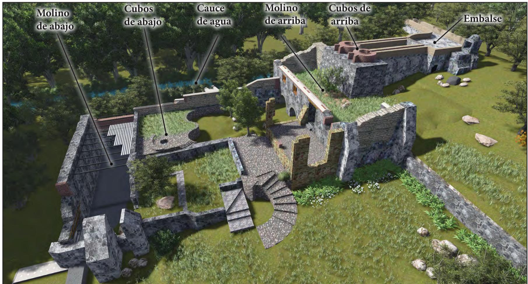
Fig.46. Perspectiva de estado actual de los molinos de Zavaleta, señalando la ubicación de sus partes.
