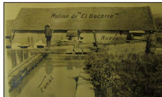
Fig.105. Imagen del año 1912 del molino de “El Socorro” donde se aprecia parte de su infraestructura hidráulica, y se señala el sitio donde se ubicó la rueda vertical. Es de notarse que la tipología corresponde a la de la ruina actual, siendo más notorio ello en el remate de los contrafuertes. Fuente: AHA, Aprovechamientos Superficiales, Caja 1256, Exp. 17247.
