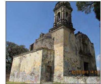
Fig.131. Imagen de la capilla de la hacienda Tomacoco, donde se observa que pese al estado de deterioro de sus fachadas, se encuentra íntegra. Febrero 2015.
