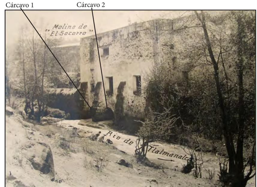
Fig.108. Imagen del molino Del Socorro del año 1912, donde se observa la fachada de lo que fue el molino de rodezno, en la parte baja se observan un par de bóvedas, que seguramente pertenecen a dos cárcavos, donde se ubicó la maquinaria inferior del molino, Fuente: AHA, Aprovechamientos Superficiales, Caja 1256, Exp. 17247.
