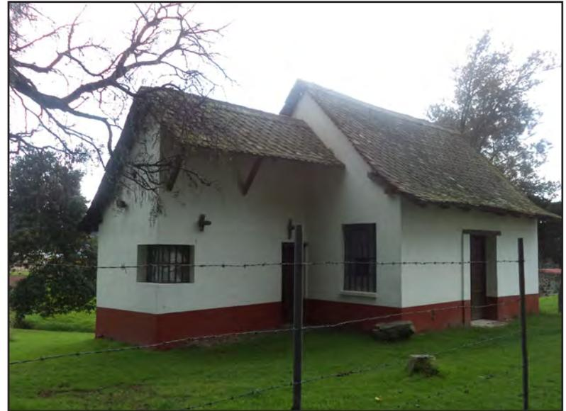
Fig.157. Edificación en la hacienda Panoaya, la cual alberga, el museo, Charles Darwin, podemos ver que al igual que la casa grande este edificio fue totalmente restaurado, recuperando el sistema constructivo original de la cubierta a base de vigas de madera y cubierta de tejamanil. Octubre 2013.
