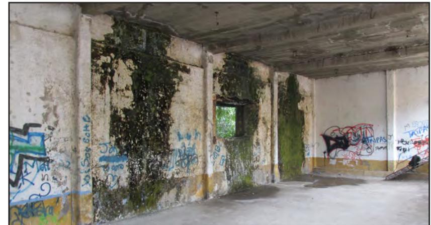
Fig.109. Imagen actual del interior del sitio donde se ubicó el molino Del Socorro, se observan sus muros, cubierta y piso totalmente intervenidos, aún así la ventana es de fábrica original, y lo podemos constatar en la imagen anterior de 1912, donde se observa la misma, ubicada en el tercer piso de su fachada. Mayo 2015.
