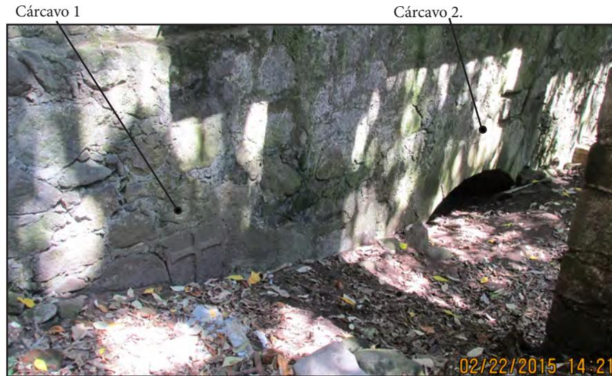
Fig. 132. Imagen de los supuestos cárcavos del molino de Tomacoco, el de la izquierda totalmente enterrado, mientras que el de la derecha parcialmente cubierto permite acceder a su interior. Hay que destacar que la clave de los arcos se ornamentó con una cruz labrada. Febrero 2015.
