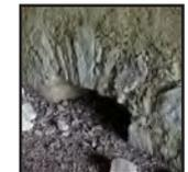
Fig.82. Nicho de viga de soporte.
