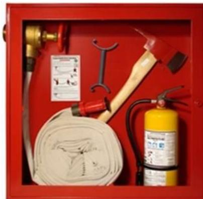
Hacha contra incendios y extinguidor: Útiles para combatir incendios, dentro y fuera de las instalaciones. El hacha con pico permite la sofocación de cualquier conato de incendio, mientras que el extinguidor lo erradica.
