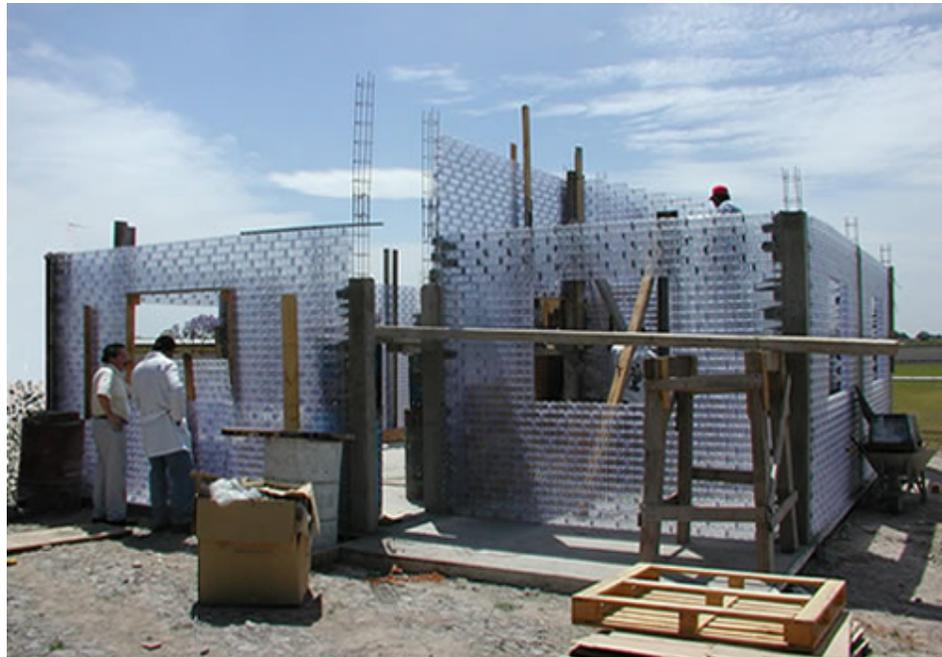
**Ilustración 1 Construcción mediante botellas de PET.**
