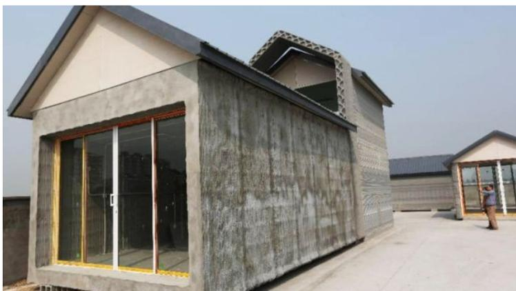
**Ilustración 25 Modelo de vivienda impresa con materiales reciclados**
