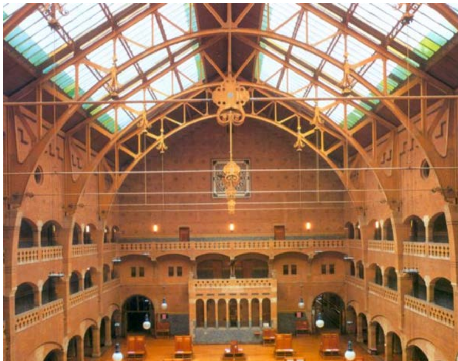
Fotografía 1. Hendrick Berlage. Salón principal de la Bolsa de Valores de Ámsterdam (1897-1903). Destaca la cubierta a 22 metros de altura, formada por armaduras de arco de medio punto con techo de paneles dobles de vidrio; evidenciando las líneas de fuerza en la estructura propuestas por el Racionalismo Arquitectónico.
