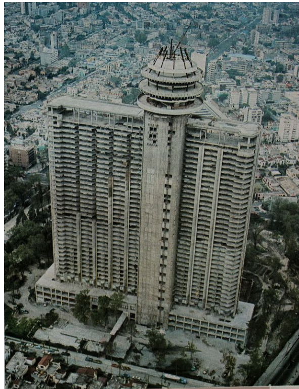
Fotografía 35. Vista aérea de las últimas etapas de construcción del Hotel de México (hoy WTC México), se observa la estructura original con el acabado de concreto de 54 niveles.
