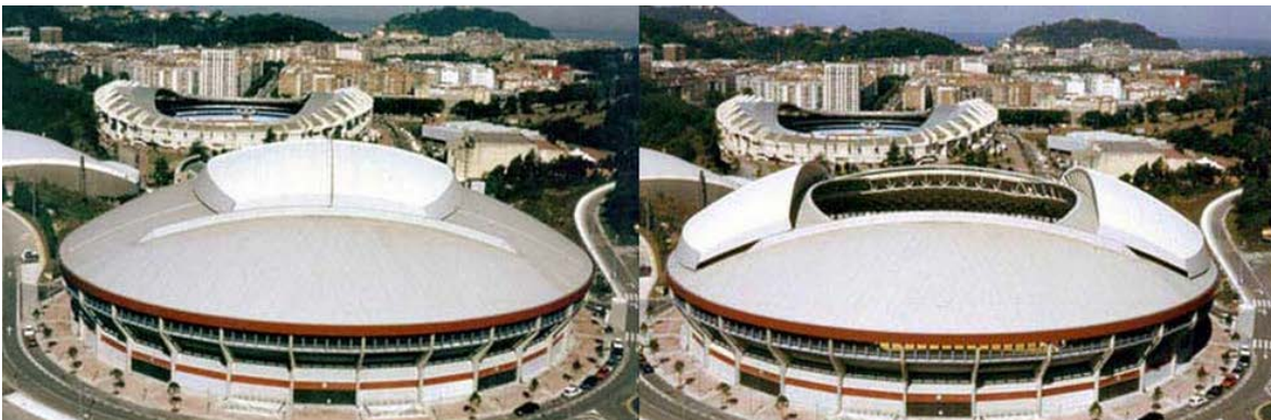
Fotografía 45. Lanik I. Vista aérea de la plaza de toros de Illumbe (Donostia Arena). A la izquierda el edificio con la cubierta retráctil cerrada, a la derecha con la cubierta retráctil abierta.
