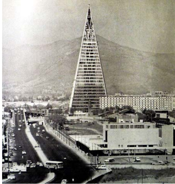
Fotografía 28. Mario Pani. Torre Insignia. Ciudad de México. (1962). Con 26 niveles y 127 metros de altura, destaca en la parte superior el carillón de 26 toneladas.
