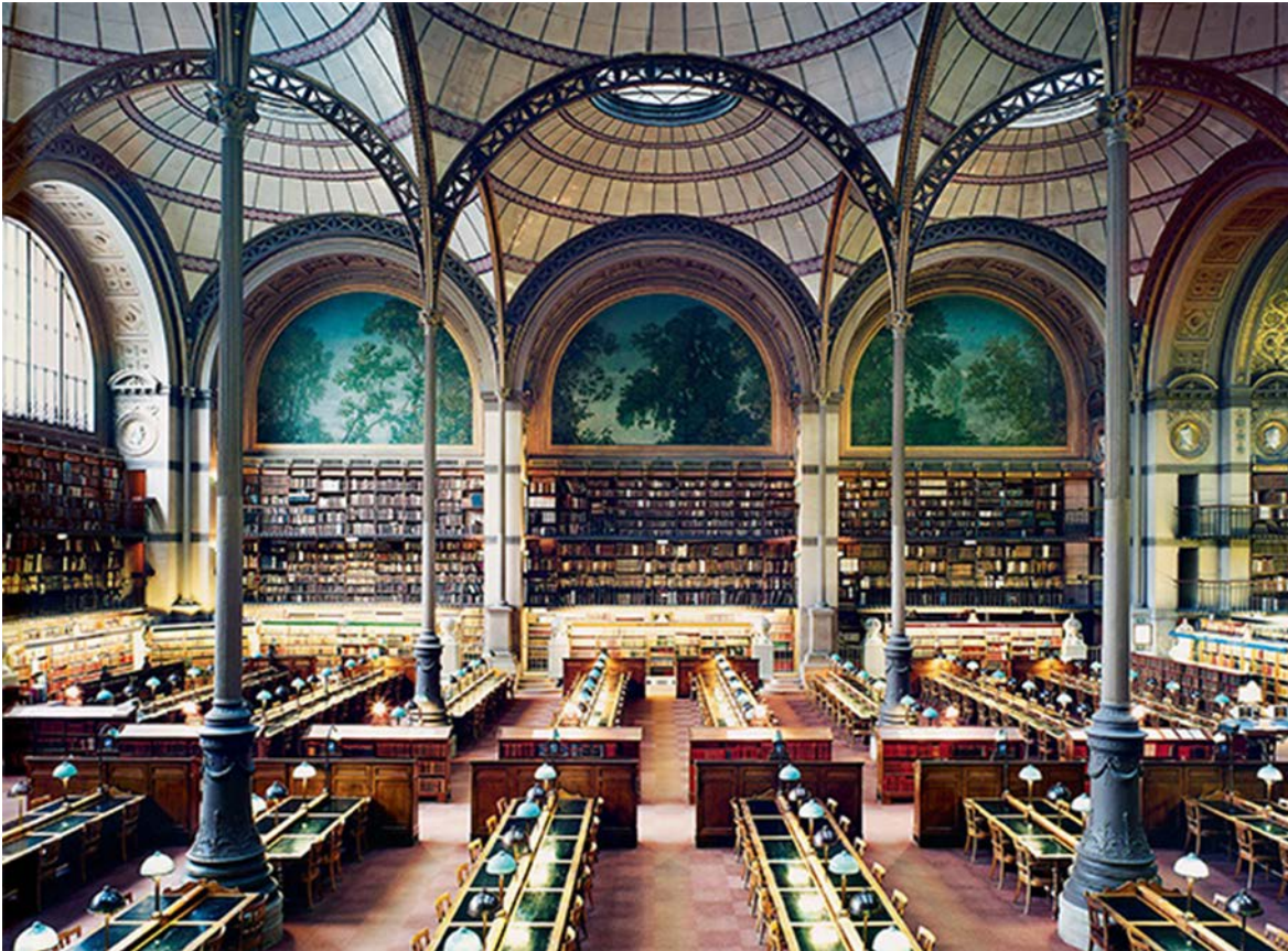
Fotografía 2. Henri Labrouste. Interior de la Biblioteca Nacional, París, Francia. (1860-1868). Sala Labrouste compuesta por dieciséis columnas de hierro de 30 cm de anchura y 10 metros de altura, cubriendo un área de 1,150 m 2 (claros aprox. de 11 metros). Labrouste propone que la ornamentación debe proceder de la estructura misma.
