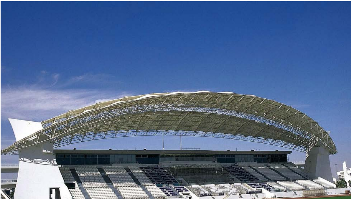
Fotografía 48. Perry Ellis, Rice / MERO. Vista desde el campo del estadio Sheikh Khalifa. La cubierta curva se apoya sobre dos grandes pilares a los extremos.
