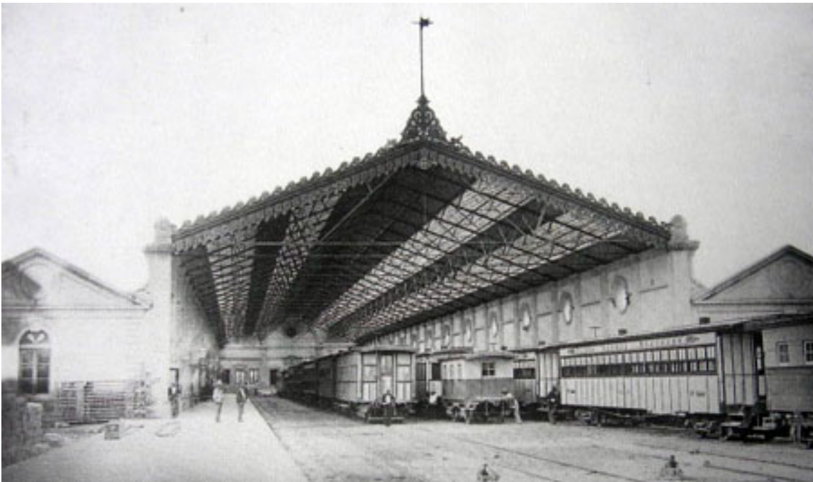
Fotografía 24. Vista de la estructura de los andenes de la Estación del F. C. Mexicano. La cubierta inclinada en dos sentidos se conforma por armaduras metálicas revestidas por paneles y apoyadas sobre muros de piedra, librando un claro de aprox. 30 m.
