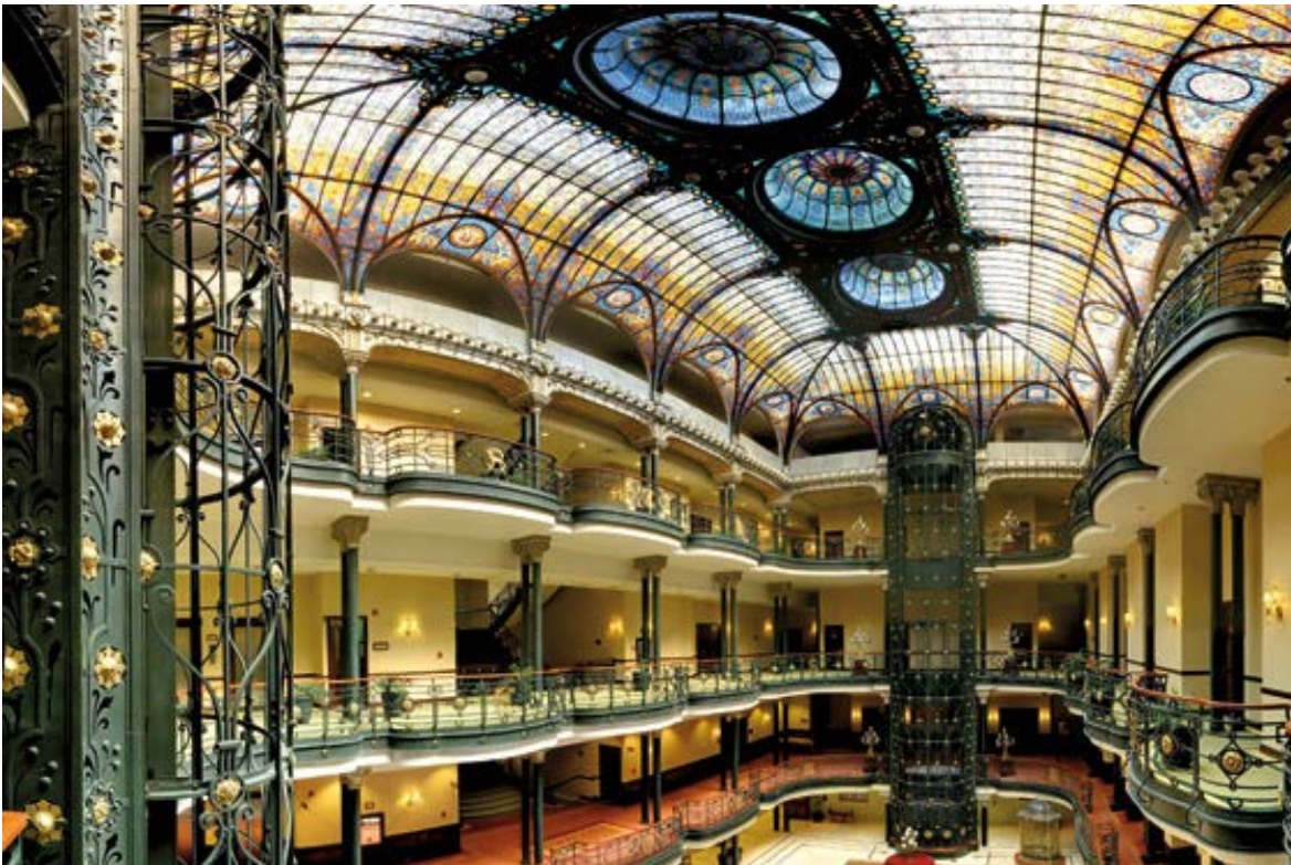
Fotografía 23. Interior del Gran Hotel de la Ciudad de México. Destaca la esbelta sección de la cubierta, la herrería y la cristalería tipo Tiffany, con dimensiones de 13 metros de ancho por 21 metros de largo.
