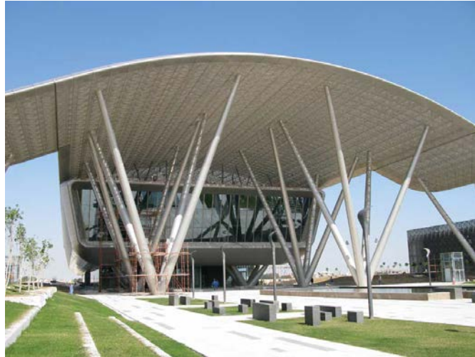
Fotografía 46. MERO. Cubierta de la terraza externa del complejo urbano “Education City”, Doha. Se observa la cubierta topológica formada por una retícula espacial apoyada sobre pilares diagonales de acero.
