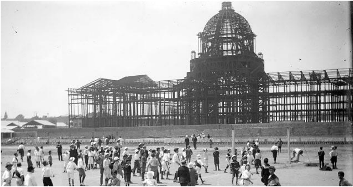
Fotografía 26. Emile Bernard. Etapa de construcción del Palacio Legislativo, Ciudad de México. Destaca el avance de la obra de la estructura de acero, con la cúpula de 67 metros actual Monumento a la Revolución.
