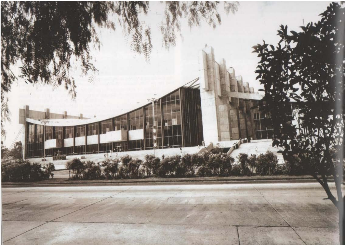
Fotografía 29. Alberca olímpica Francisco Márquez. Fotografía desde la avenida División del Norte. Se observa la estructura de catenaria sustentada por los apoyos de 32 y 37 m de altura.
