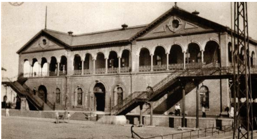
Fotografía 19. Aduana de Tampico, Tamaulipas. (1896.) Posee elementos estructurales prefabricados en hierro fundido, como las armaduras de las cubiertas y las esbeltas columnas.
