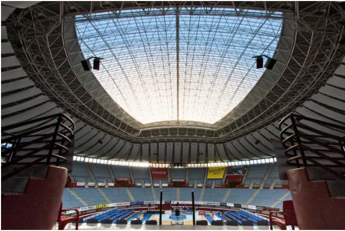
Fotografía 44. Lanik I. Interior de la plaza de toros de Illumbe (Donostia Arena), se observan dos partes diferentes de la cubierta, la estática con paneles opacos y la retráctil con paneles translúcidos.
