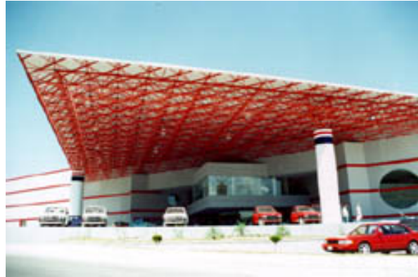
Fotografía 37. Estructura en voladizo de la cubierta de acceso del Auto Show de Monterrey, con 30 m de armaduras en voladizo.
