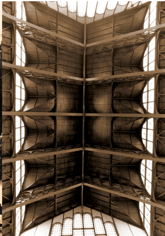
Fotografía 21. Interior, vista de la cubierta del “Palacio de Cristal”, en Santa María la Rivera, Ciudad de México. (1903). Con una superficie total cubierta de 1500 m 2 , las naves laterales tienen una altura de 19 m y la nave central de 32 m.
