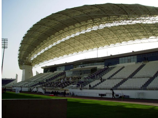
Fotografía 49. Perry Ellis, Rice / MERO. Tribunas del estadio Sheikh Khalifa. Se observa la malla de fibra de vidrio y la cubierta espacial tridimensional curva con la abertura central.
