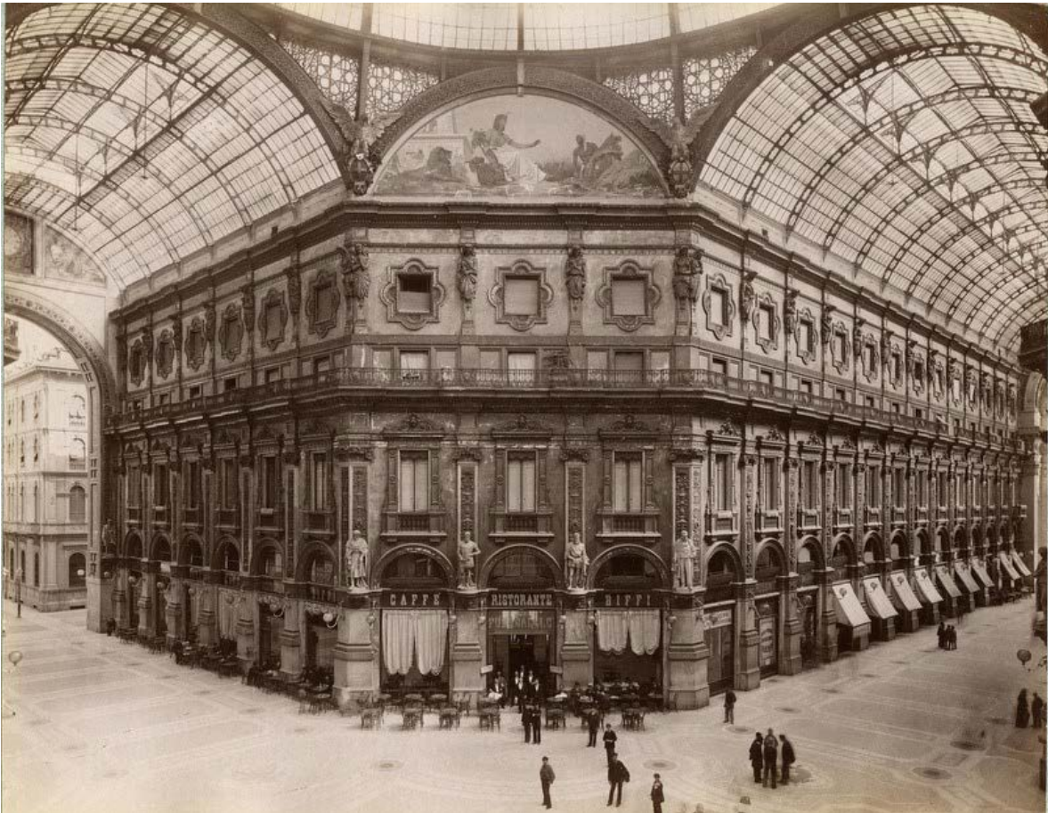
Fotografía 3. Giuseppe Mengoni. Interior de la Galería Vittorio Emanuele. (1880). Se observan las galerías formadas por bóvedas con estructura de hierro y cubierta de cristal con claros de aprox. 15 metros, alzando la cúpula de 36 metros de diámetros a 47 metros de altura.
