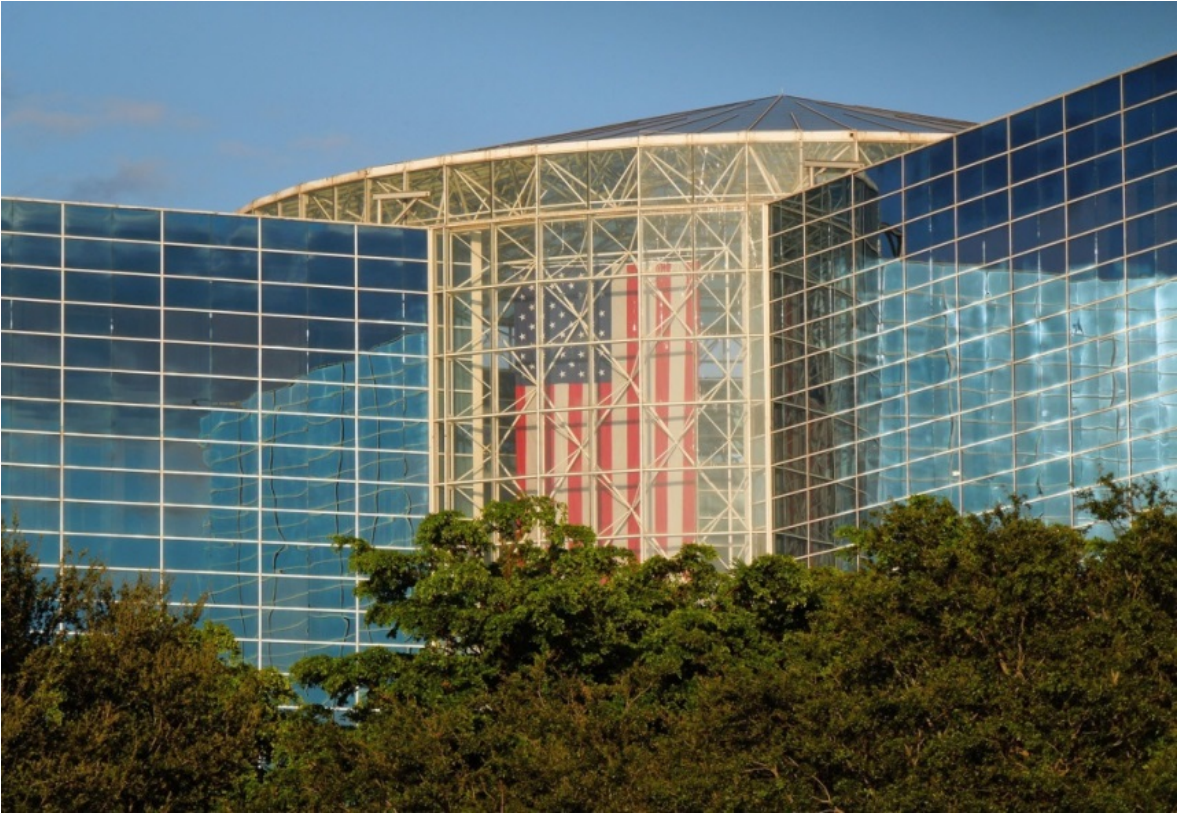
Fotografía 12. Barreta & Associates. Fachada-cubierta de cristal con el sistema MERO, del Presidential Circle Office en Hollywood, E.U.A.
