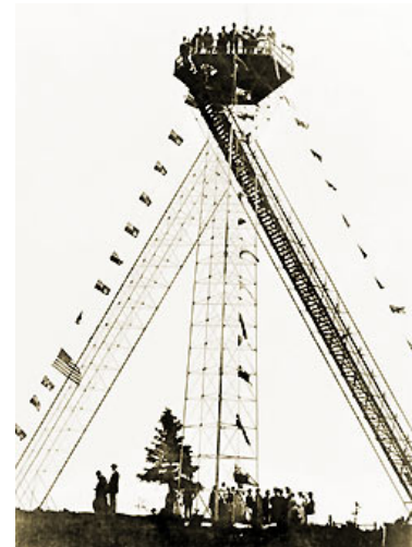
Fotografía 6. Graham Bell (1907). Estructura espacial "Torre Bell", formada por células tetraédricas de tubos de hierro de 4 ft de longitud, alcanzando una altura total de 75 metros. Nueva Escocia, Canadá.
