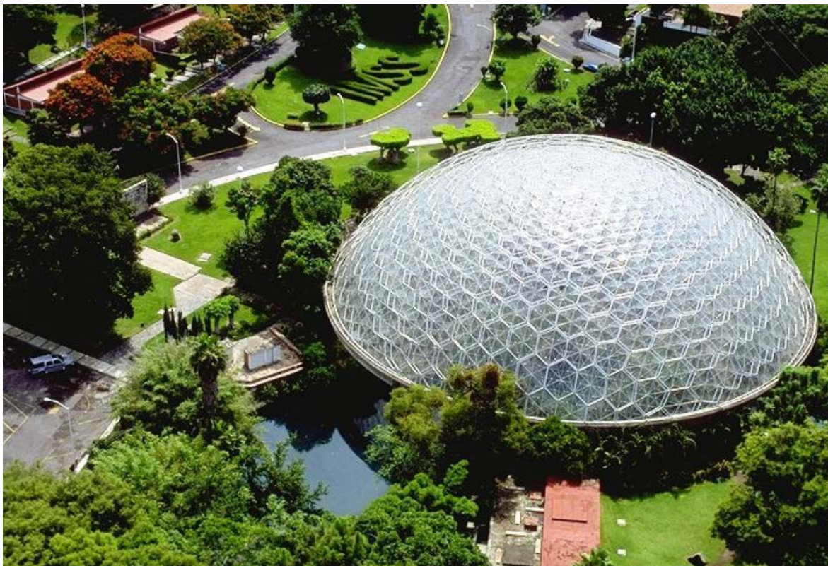
Fotografía 30. Prieto Posada. Domo de las Fuentes Termales. Oaxtepec, Morelos. (1966). Destaca la estructura metálica de la cúpula de 35 metros de radio y 23 metros de altura (desde el suelo), compuesta por módulos hexagonales al exterior y triangulares al interior.
