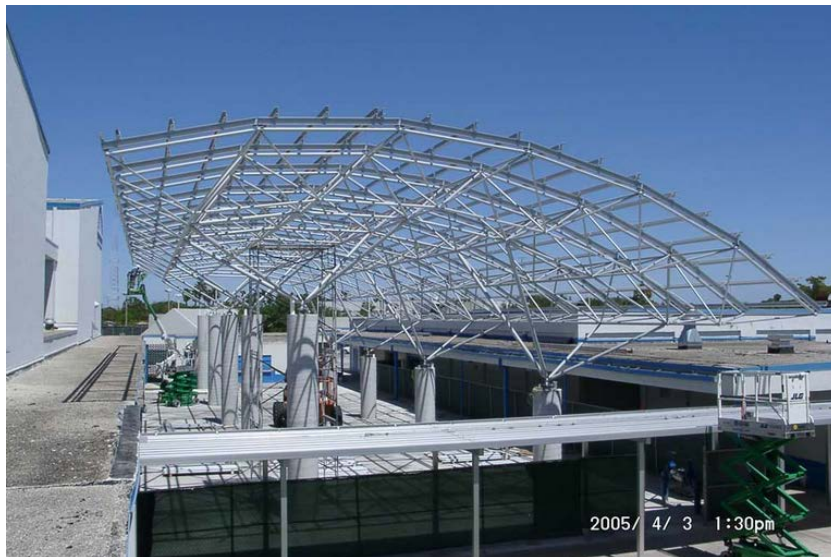
Fotografía 43. Lanik I. Cubierta del patio exterior de Dillard High School. Con 50 metros de longitud por 20 metros de anchura, utiliza el sistema Ortz de Lanik, formada por una retícula espacial de semioctaedros.
