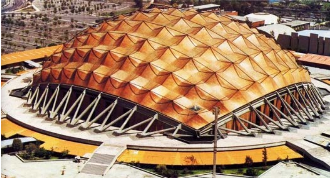
Fotografía 31. Félix Candela. Palacio de los Deportes. Con un claro máximo de 160 m y una superficie cubierta de 27 mil m 2 , destaca la cubierta revestida en cobre y la estructura geodésica compuesta por paraboloides hiperbólicos.
