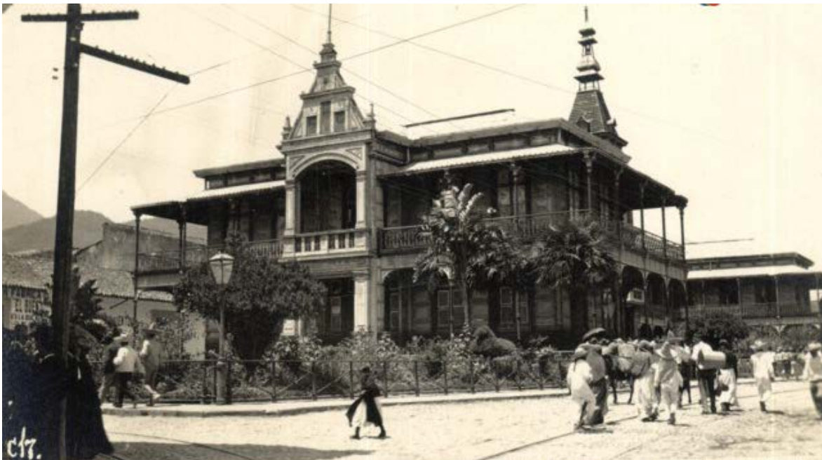
Fotografía 20. Antiguo Palacio Municipal de Orizaba, Veracruz. (1894). Construido fundamentalmente en acero y hierro fundido, bajo el diseño de Gustave Eiffel, con un peso total de 600 toneladas.
