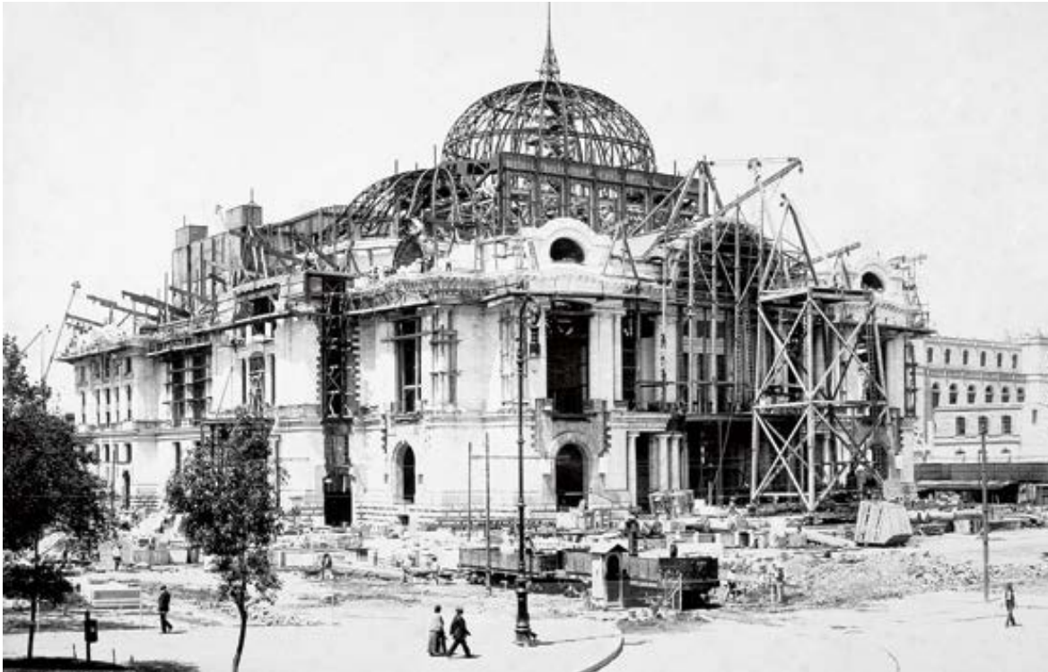
Fotografía 25. Adamo Boari. Etapa de construcción del Palacio de Bellas Artes, Ciudad de México. (1910). Destaca la estructura metálica revestida por el mármol, con una altura al techo de 42.5 m y una altura total de 53 m.
