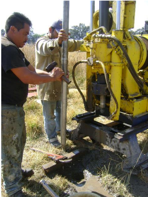
OBTENCIÓN DE MUESTRAS ALTERADAS CON EL TUBO PARTIDO.
