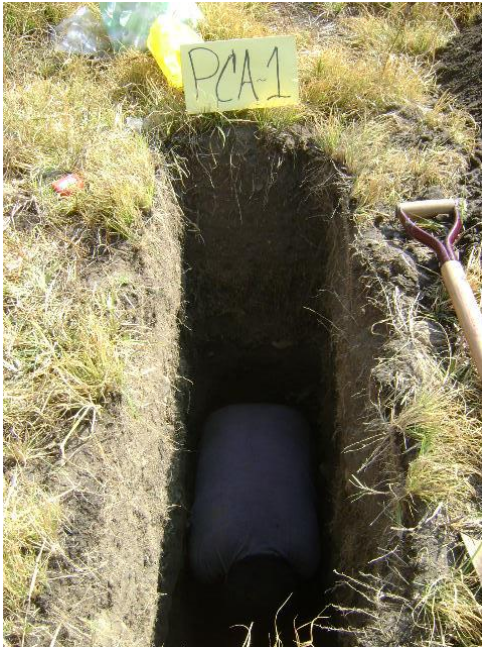
TRABAJOS DE EXCAVACIÓN PARA LA ELABORACIÓN DEL POZO A CIELO ABIERTO, DENOMINADO PCA-1.
