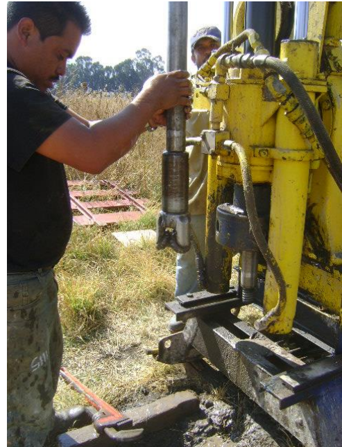
BROCA TICÓNICA, LA CUAL REALIZA EL AVANCE EN LA PERFORACIÓN.
