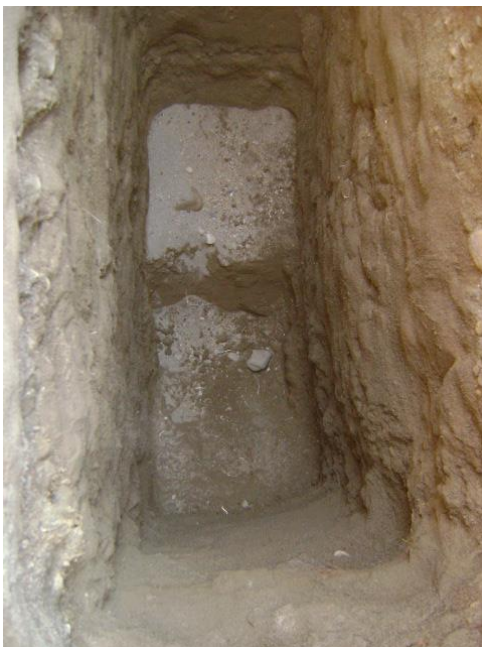
EN LA IMAGEN SE APRECIA LA ESTRATIGRAFÍA PROPIA DEL SITIO, LA CUAL SE ENCUENTRA CONSTITUIDA EN SUS PRIMEROS METROS POR UNA ARENA LIMOSA.
