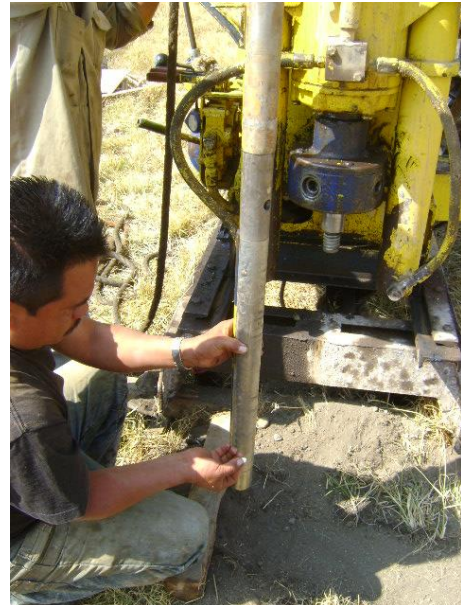
EN LA IMAGEN SE PUEDE VER EL INICIO DE LA PERFORACIÓN PARA EL SONDEO MIXTO, LA CUAL SE REALIZA CON EL TUBO
