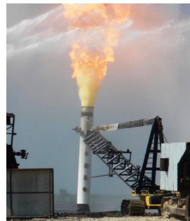
Figura 83 Ducto de escape de hidrocarburos instalado después del corte.
