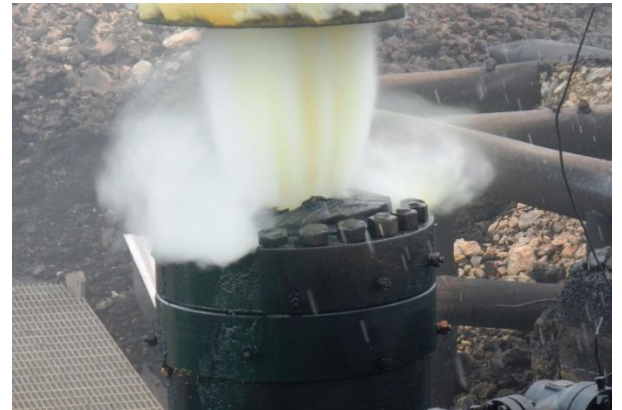
Figura 79 Instalación de salida vertical para alejar el fuego.
