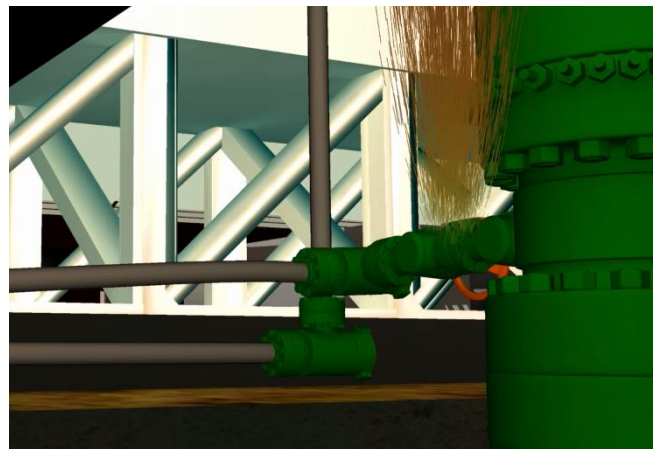
Figura 77 Fuga de hidrocarburos por válvula lateral
