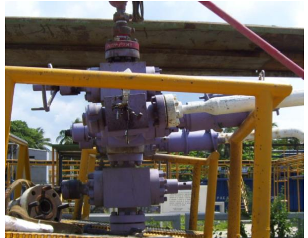
Figura 63 Salidas lateral sostenidas en andamio.
