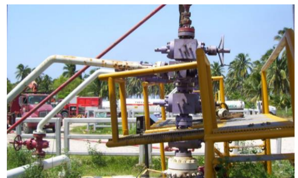
Figura 65 Vista lateral del contacto entre salidas laterales del pozo con andamio.
