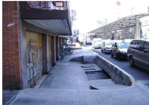
Imagen 2. Av. Cuauhtemoc. La banqueta se encuentra bajo el nivel del carril vehicular. En estas condiciones es fácil que el agua se acumule.
