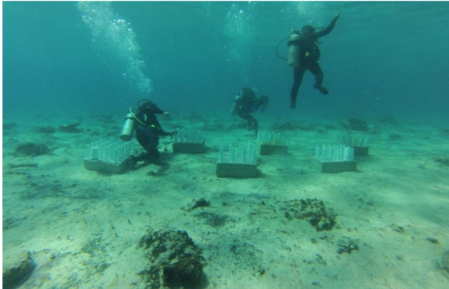
Figura 5. Plataformas de concreto adheridas al suelo conformando el vivero marino.
