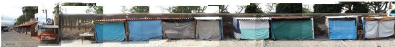
Vista NORTE de la calle Zapata. Tramo C. Fotos del autor
