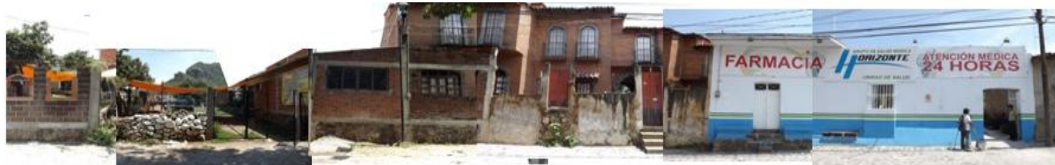
Vista SUR de la calle Francisco I. Madero. Tramo C. Fotos del autor
