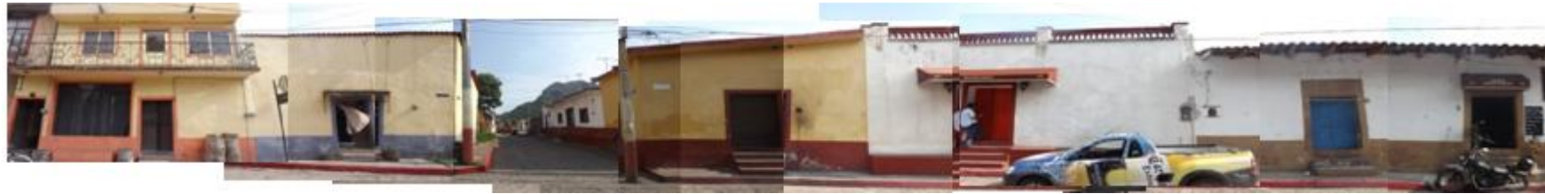
Vista SUR de la calle Zapata. Tramo C. Fotos del autor
