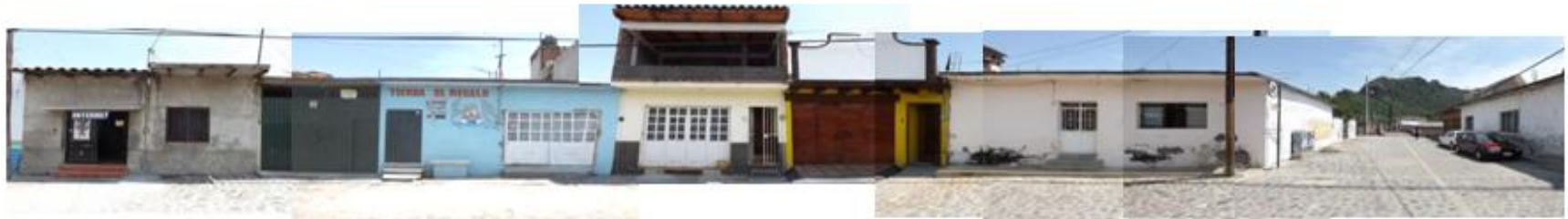
Vista SUR de la calle Francisco I. Madero. Tramo D. Fotos del autor
