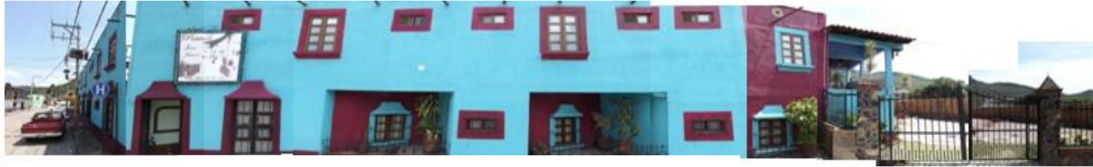
Vista SUR de la calle Francisco I. Madero. Tramo A. Fotos del autor
