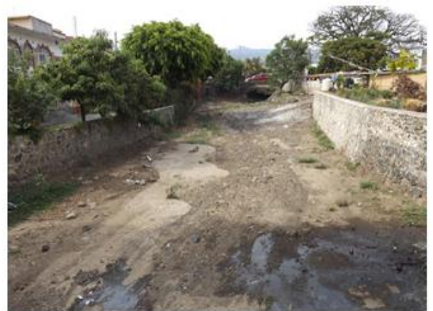
Figura 50. Vista hacia el norte. Sin cauce. Foto del autor
