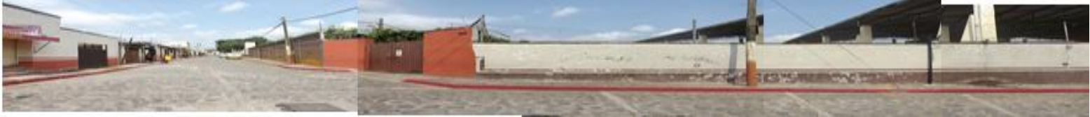
Vista ESTE de la calle Justo Sierra. Tramo A. Fotos del autor
