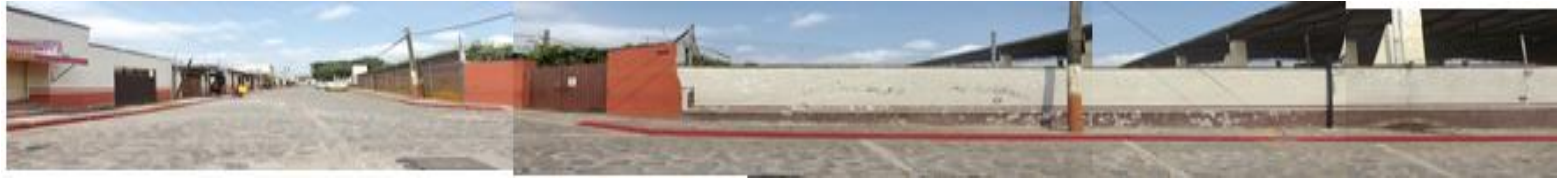
Vista ESTE de la calle Justo Sierra. Tramo A. Fotos del autor
