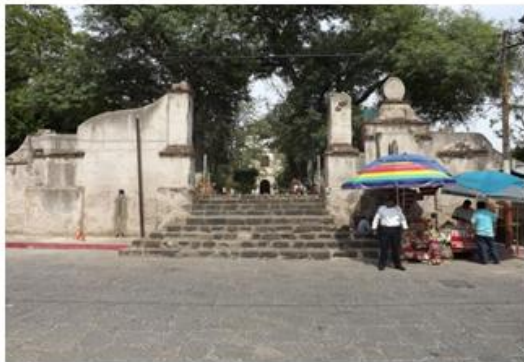
Figura 43. Vista hacia el este. Se encuentra el acceso al Ex Convento. Foto del autor
