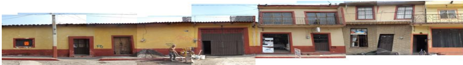
Vista SUR de la calle Zapata. Tramo B. Fotos del autor
