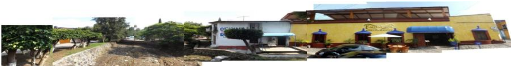
Vista SUR de la calle Zapata. Tramo G. Fotos del autor
