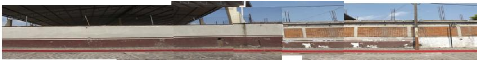
Vista ESTE de la calle Justo Sierra. Tramo B. Fotos del autor
