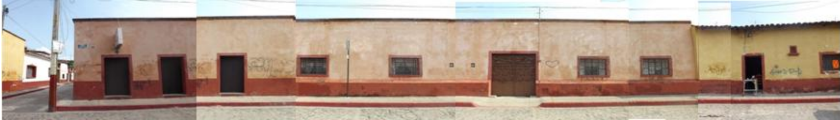
Vista SUR de la calle Zapata. Tramo A. Fotos del autor
