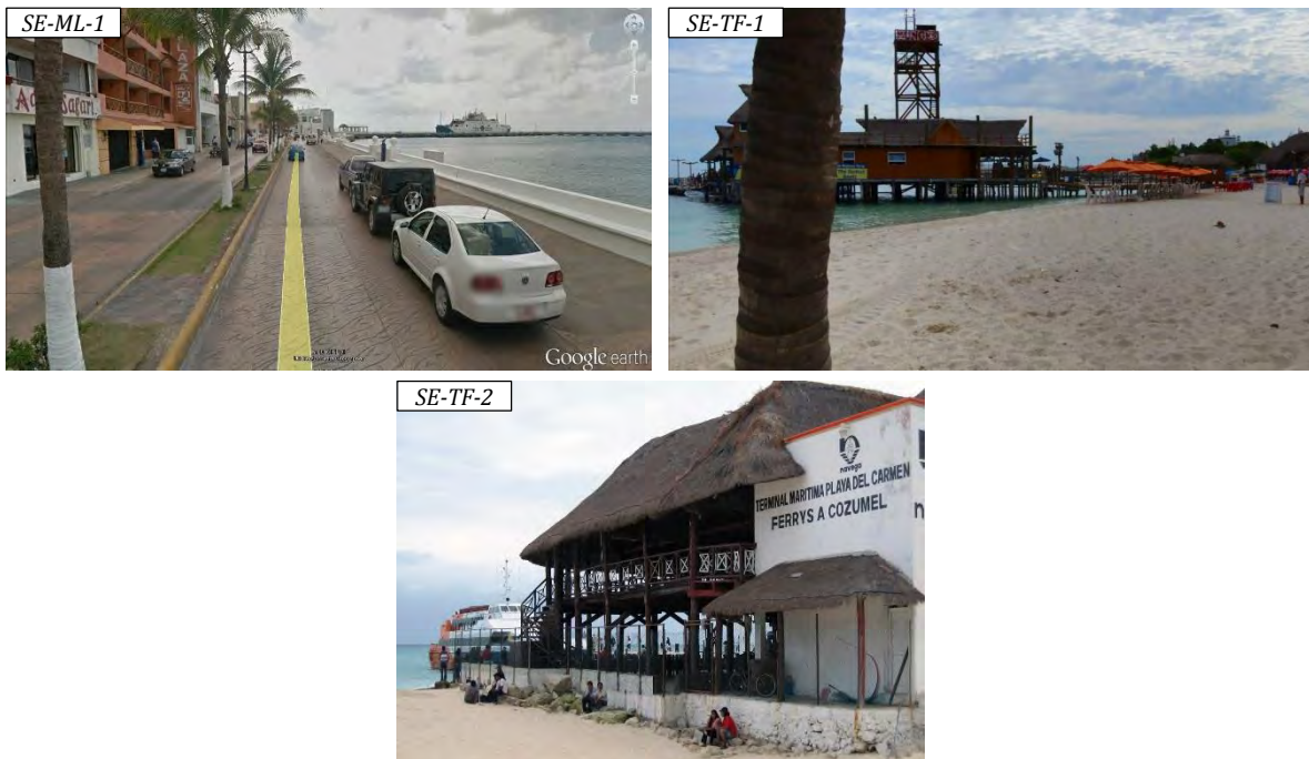
Figura 3.39. Infraestructura portuaria en su estado actual (Google Street View – Panoramio 2015)
