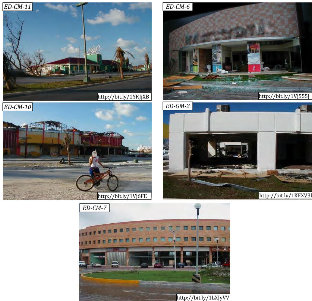
Figura 3.8. Daños en comercios
