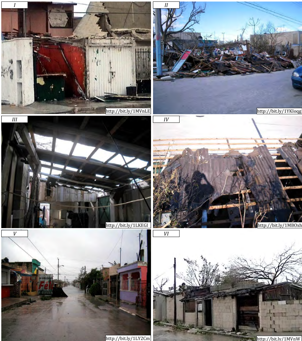
Figura 3.46. Daños en viviendas en la Colonia "Región 94" de Cancún, Quintana Roo.
