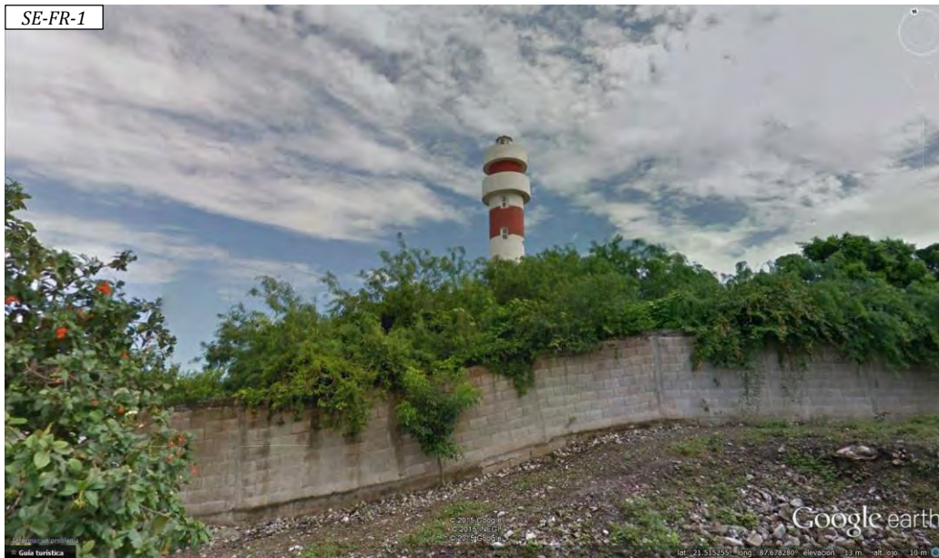
Figura 3.37. Faro de El Cuyo en su estado actual (Google Street View 2013)
