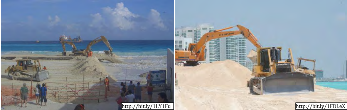
Figura 3.41. Trabajos de recuperación de playas en Cancún
