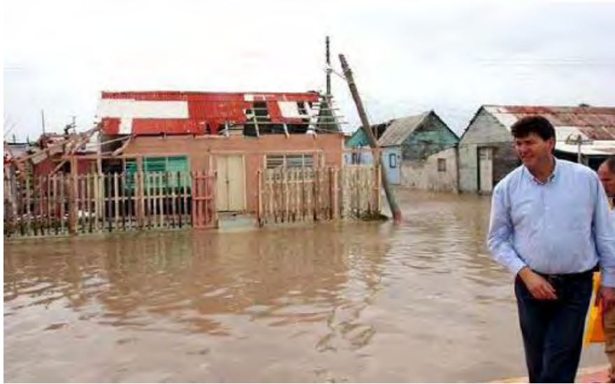
Figura 3.44. Viviendas dañadas en el estado de Yucatán
