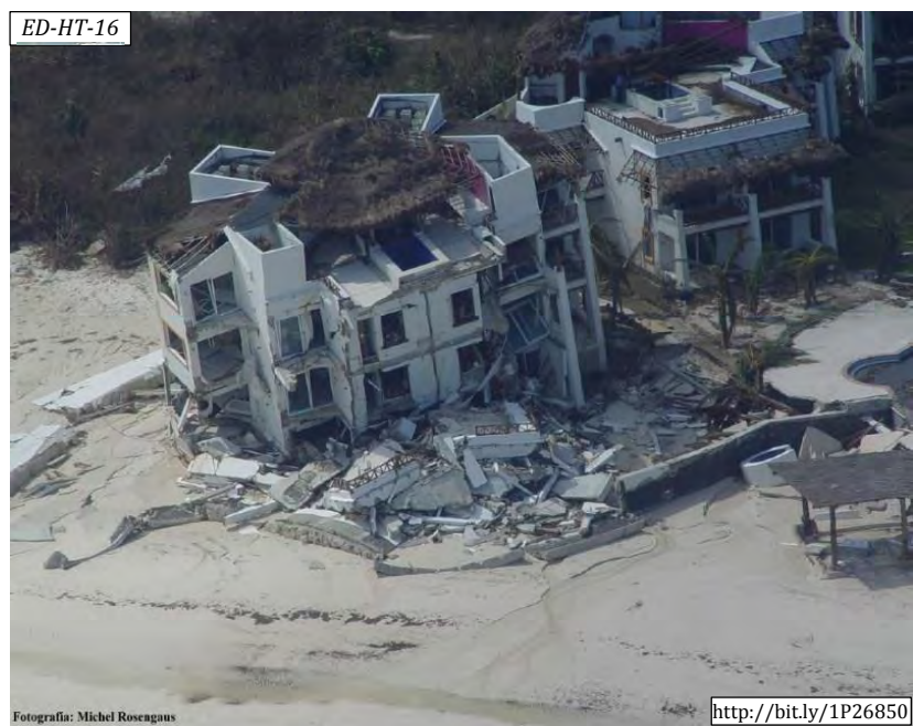
Figura 3.16. Hotel con daño estructural en Puerto Morelos (Fotografía: Michel Rosengaus)
