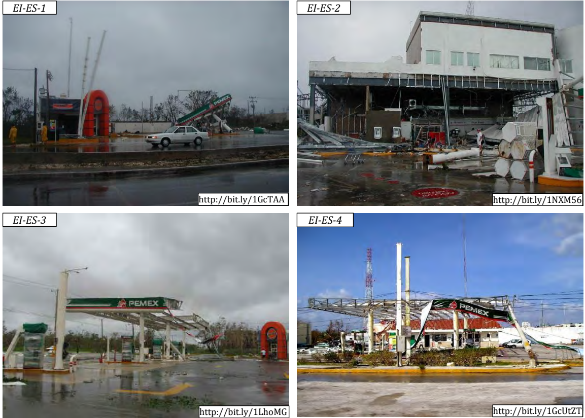
Figura 3.23. Daños en estaciones de servicio
