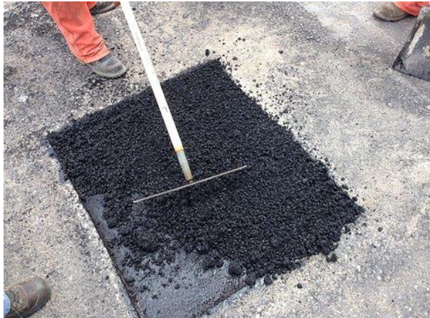
Figura 2.3. Colocación de mezcla asfáltica fría
