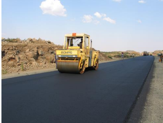
Figura 2.7. Uso del concreto asfáltico en carreteras
