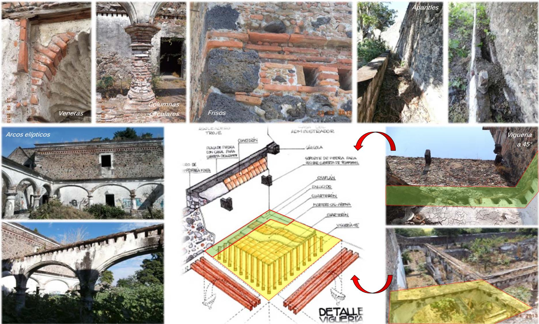
Figura 2-5 Diseño propio y detalles de San Miguel Treinta: uso del tabique, apantles, arcos carpanel de tres centros y viguería a 45° en el cruce de crujiás.
