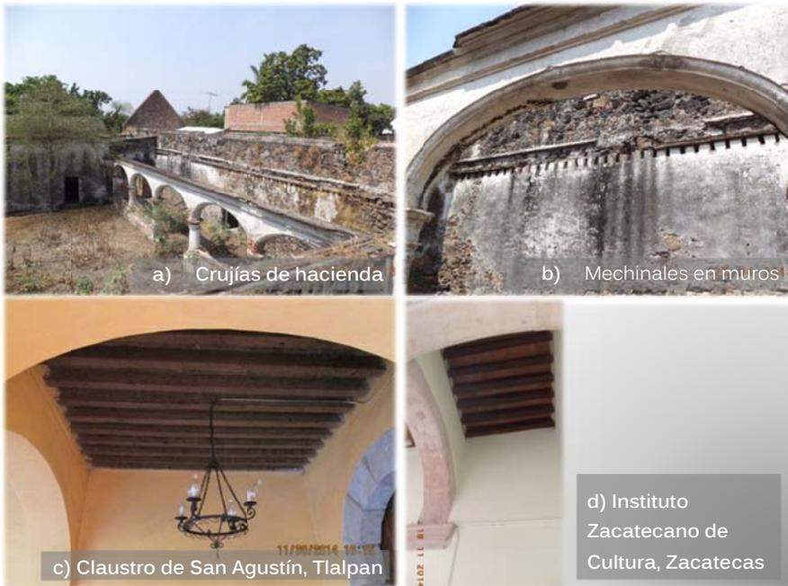
Figura 3-18 Análogos de vigerías: a) y b) Crujías y mechinales de la hacienda; c) y d) Disposición de vigas en cruce de crujías. Hernández Avilés, 2013-2014.
