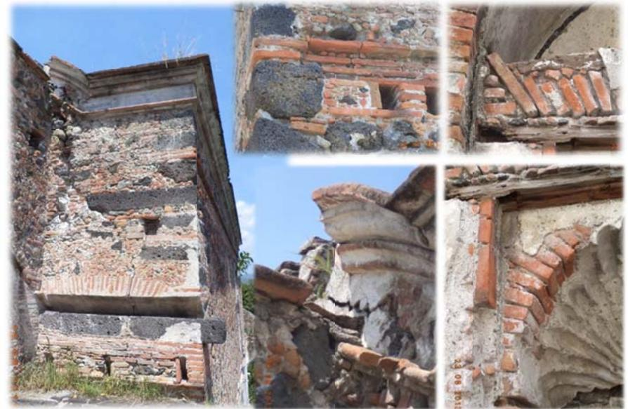
Figura 3-23 Detalle del aparejo en muros, cornisas y venteras.
