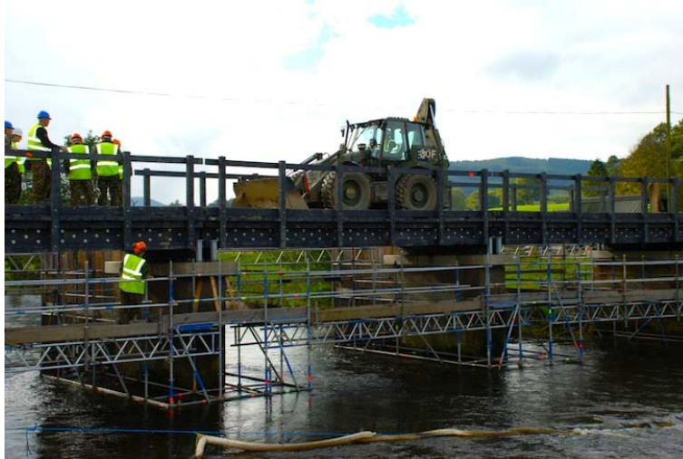
Ilustración 6: Puente hecho a base de PEAD reciclado en proceso de construcción (Vertech, 2013)
