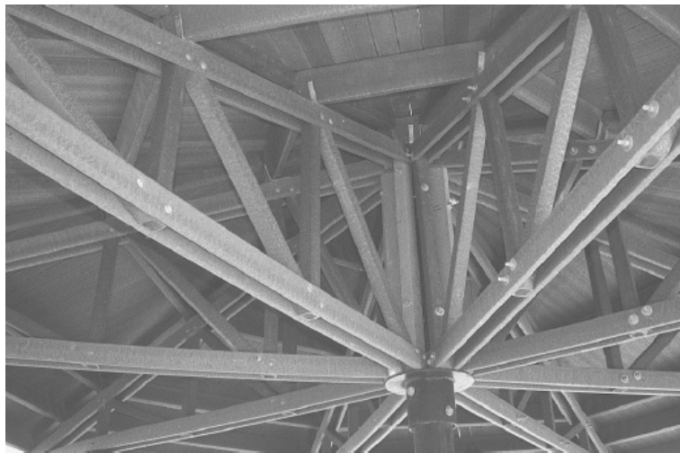
Ilustración 12: Detalle de uniones en la cubierta de un mirador (G. Lampo & J. Nosker, 1997, pág. 76)
