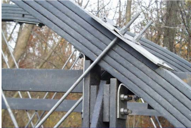
Ilustración 14: Detalle de placa con varilla (McLaren Engineering Group, 2003, pág. 55)
