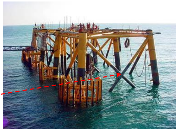
Fig. 3.5. Diagonales de la subestructura en X
