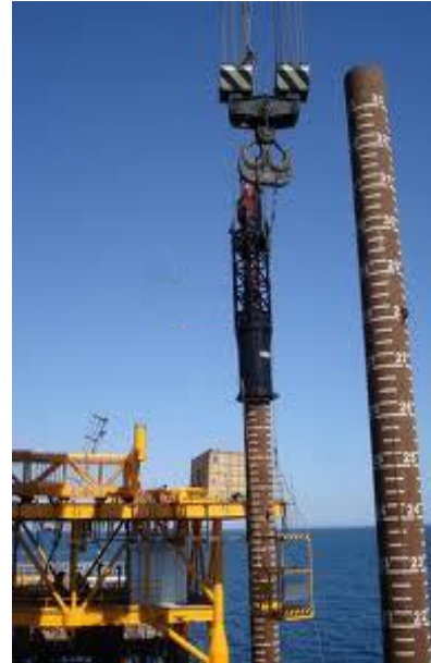
Fig. 4.3. y Fig. 4.4. Fabricación e hincado de pilotes.
