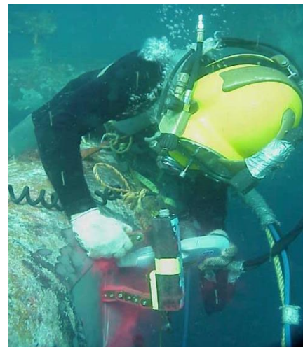
Fig. 7.1 y Fig. 7.2 Inspección submarina del Jacket.
