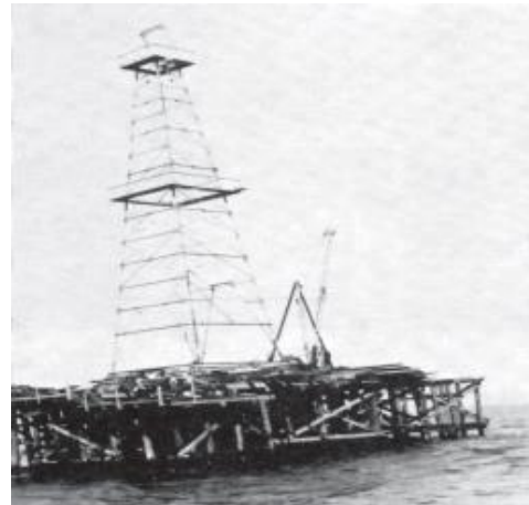
Fig. 1.2. Plataforma construida de madera, Texas, EUA, en 1938.
