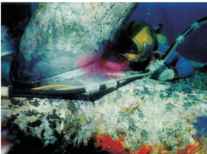
Fig. 7.1 y Fig. 7.2 Inspección submarina del Jacket.
