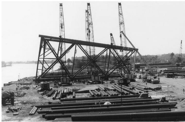
Fig. 2.6. y Fig. 2.7. Construcción de la subestructura (Jacket) en patio de fabricación y modelado en SACS de subestructura.
