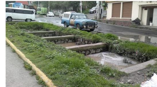
2.7. Pozos de infiltración de agua pluvial
