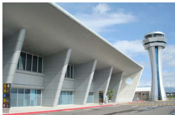
Fotografía 14. Edificio de pasajeros y torre de control del Aeropuerto Internacional de Cuernavaca.
