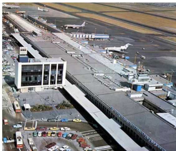
Fotografía 5. Edificio de pasajeros del AICM, el cual comenzaba a presentar saturación, al igual que el estacionamiento en 1978. Ref. 2.
