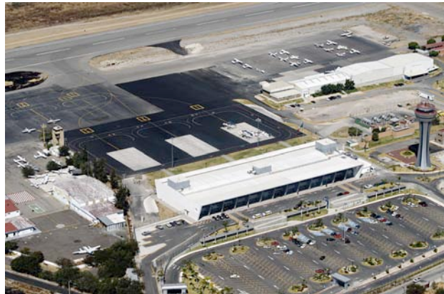
Fotografía 13. Panorámica del Aeropuerto Internacional de Cuernavaca.
