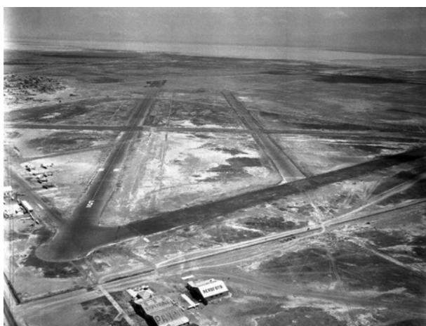
Fotografía 6. A la derecha de la fotografía se observa la construcción de la pista 05R/23L en el ya internacional Puerto Aéreo Central de la Ciudad de México, 1949. Ref. 2.
