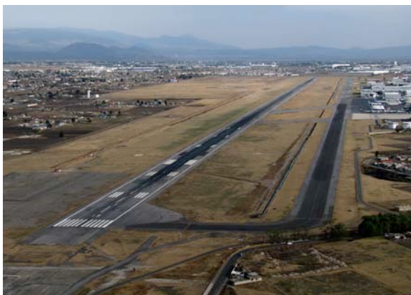
Fotografía 11. Pista 15/33 del Aeropuerto Internacional de Toluca.
